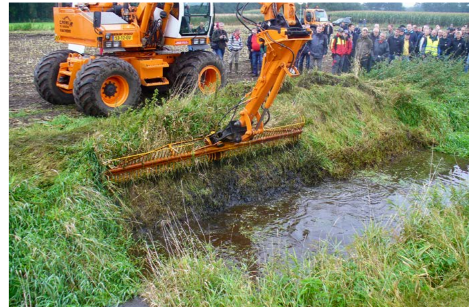
Bei Krautungs- oder Räumungsarbeiten mit schwerem Gerät sollte unbedingt abschnittsweise vorgegangen und im jeweiligen Bearbeitungsjahr nur eine Seite des Gewässers auf diese intensive Weise gepflegt werden. (Foto: J. Oldewurtel)
