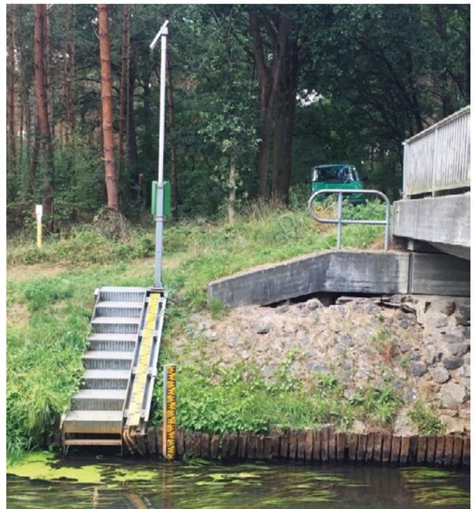
Gewässerkundliche Messstation (sog. „Kompaktstation“) mit zwei Pegelstapfeln (Senkrecht- und Schrägpegelatte) und Solarpanel zur Stromversorgung der Messtechnik.
