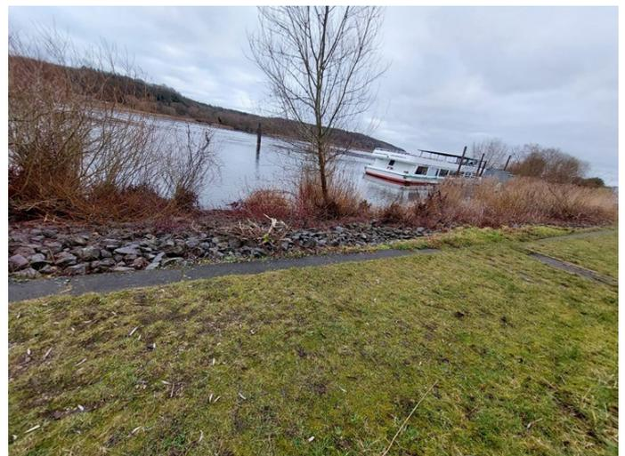
Abbildung 23: Schüttsteindeckwerk, Quelle: T. Wilhelms, 27.01.2023
