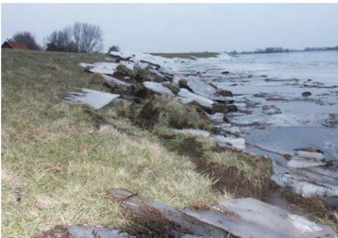
Abbildung 8: Eisschäden durch Treibeis am Deich im ADV (Januar Hochwasser 2003); Quelle: Hochwasserschutzplan Niedersachsen, Untere Mittelelbe 2006
