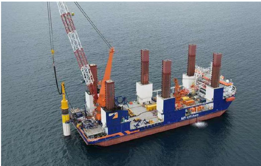
Abbildung 8 Positionierung der Monopiles vor dem Eintreiben
