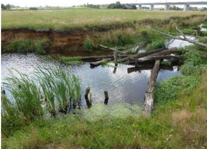
**Abbildung 6: In das neue Bett der Schunter eingebaute Totholzelemente.**
