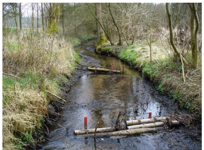
Abbildung 15: Harlinger Bach bei Tollendorf ohne (2013, oben links) und mit eingebrachten Hartsubstraten (2015, oben rechts) sowie zwischen Tollendorf und Pussade ohne (2013, unten links) und mit eingebauten Strömungslenkern aus Totholz (2015, unten rechts).
