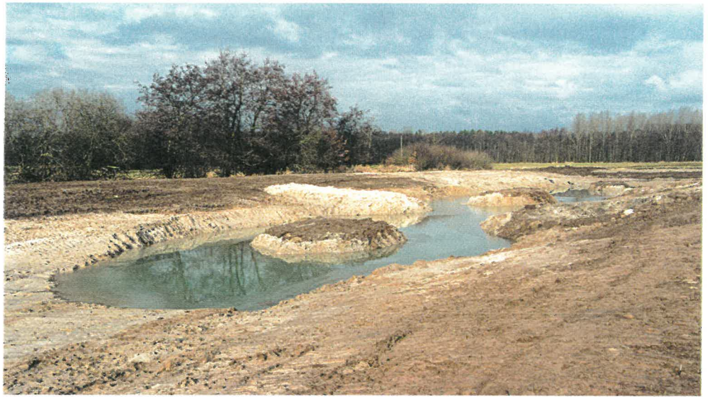
Abb. 2: Stillgewässer mit Inseln nach Abschluss der Bauphase bei noch abgesenktem Wasserstand
