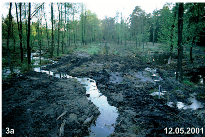
Abb. 3a und 3b: Renaturierung der Lutter im Oberlauf. Im ausgebautem Gerinne (in Blickrichtung geradeaus) wurde der Wasserstand mit einer Reihe von Querdämmen bis an die Geländeoberkante angestaut. Das Material wurde seitlich gewonnen, so dass Weihern entstanden. Dem neuen Bachlauf wurde ein kleines, gewundenes Gerinne vorgegeben (Abb. 3a: unmittelbar nach Beendigung der Baumaßnahme). Bereits nach einem Jahr erscheint die Renaturierungsstrecke naturnah (Abb. 3b).
