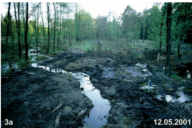
Abb. 3a und 3b: Renaturierung der Lutter im Oberlauf. Im ausgebautem Gerinne (in Blickrichtung geradeaus) wurde der Wasserstand mit einer Reihe von Querdämmen bis an die Geländeoberkante angestaut. Das Material wurde seitlich gewonnen, so dass Weiherr entstanden. Dem neuen Bachlauf wurde ein kleines, gewundenes Gerinne vorgegeben (Abb. 3a: unmittelbar nach Beendigung der Baumaßnahme). Bereits nach einem Jahr erscheint die Renaturierungsstrecke naturnah (Abb. 3b).
