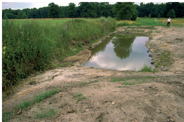
Abb. 9: Blick in Fließrichtung auf den „Sandfang Bargfeld“ im Sommer 1999, ca. ein Jahr nach Fertigstellung. Vorne links ist der zuführende Entwässerungsgraben zu erkennen. Am hinteren Ende des Sandfanges setzt sich der Entwässerungsgraben fort, gesäumt von dichter Vegetation.
