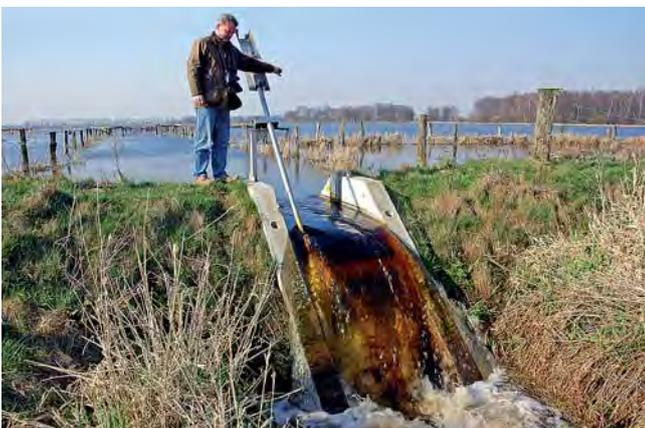
Abb. 16: Durch regelbare Stau können die Wasserstände aktiv gesteuert werden. (Foto: O. Lange)
