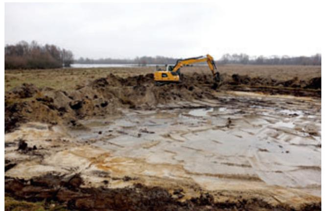
Abb. 2: Gewässerneuanlage mit dem Bagger im NSG Ilkerbruch (Foto: Joachim Neumann)
