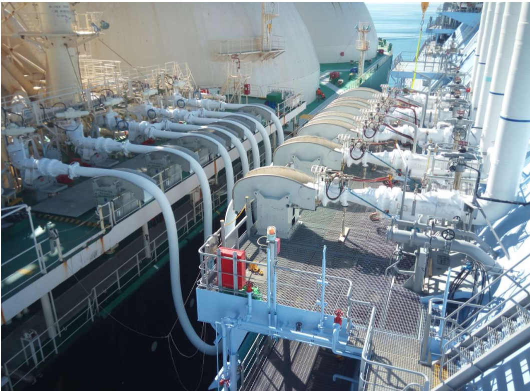
Abb. 3: LNG-Beladung von Schiff zu Schiff über kryogene Schläuche (Beispiel)
