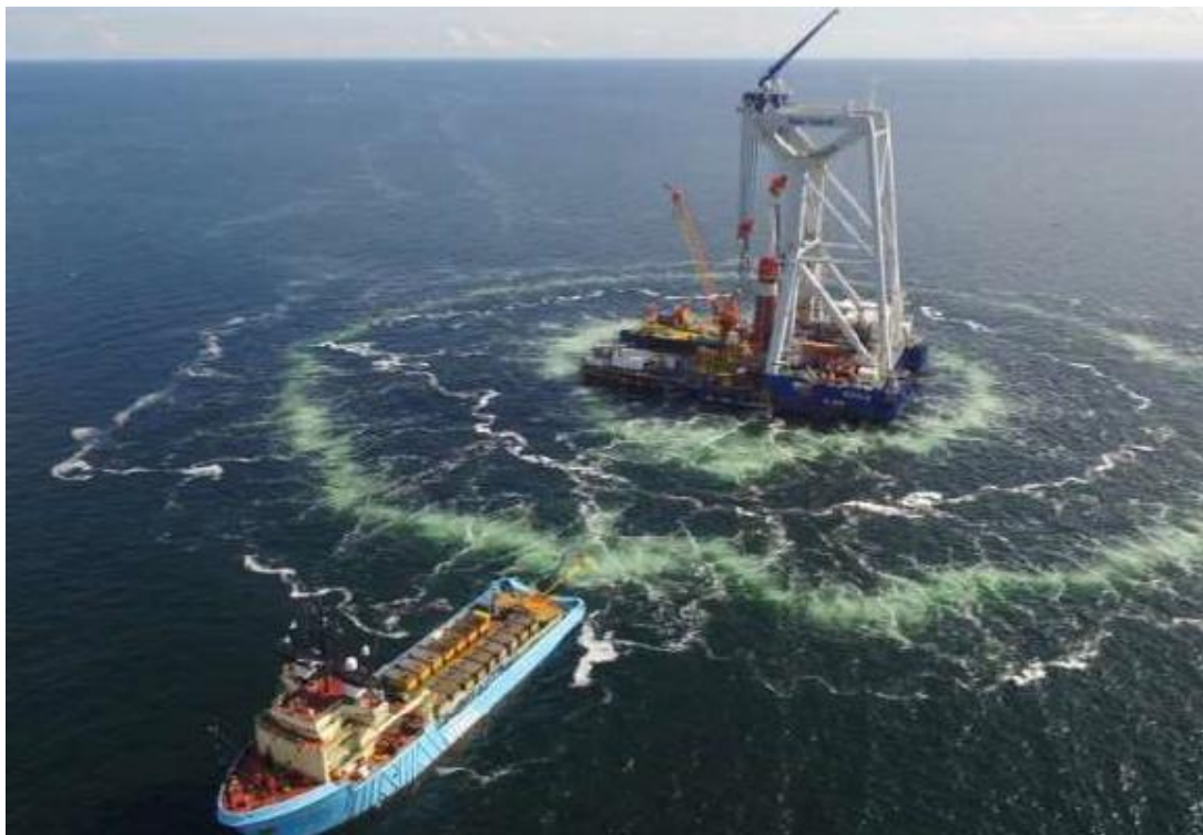
Abbildung 24 - Doppelter Blasenschleier zur Lärminderung im Einsatz
