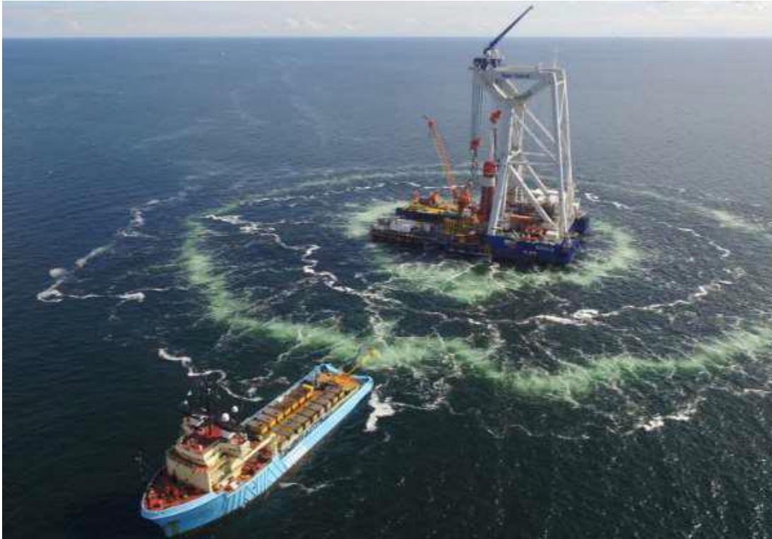
Abbildung 18: Doppelter Blasenvorhang im Einsatz
