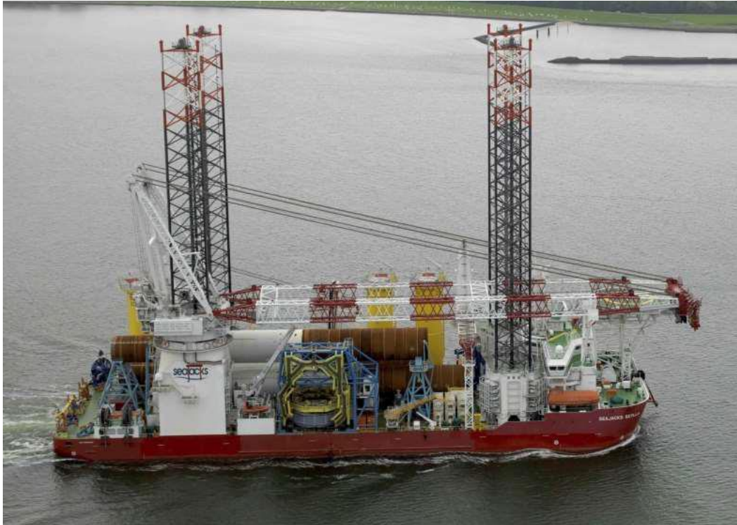
Abbildung 16: Installationsschiff zur Errichtung der Dalben (Beispiel)
