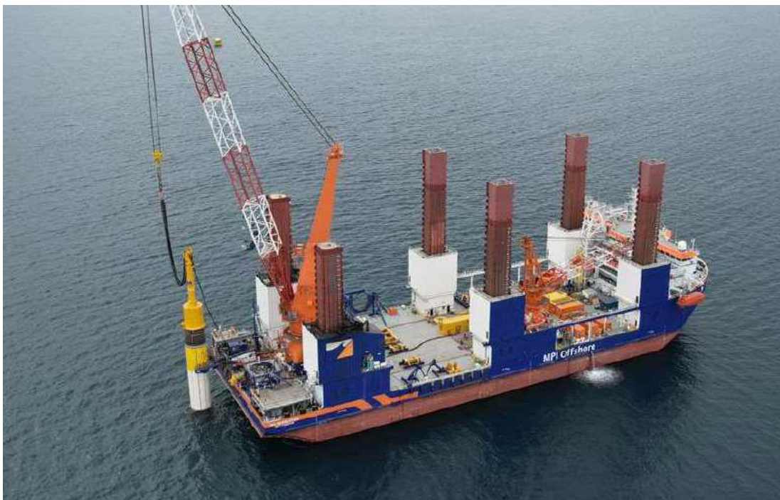
Abbildung 17: Positionierung der Monopiles vor dem Eintreiben
