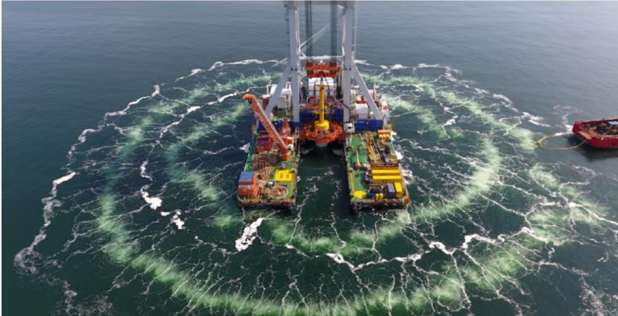
Abbildung 66: Beispiel 1 Schallminderungsmaßnahme Druckluftblasenvorhang
