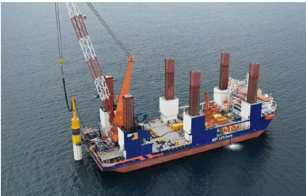
Abbildung 8 Positionierung der Monopiles vor dem Eintreiben
