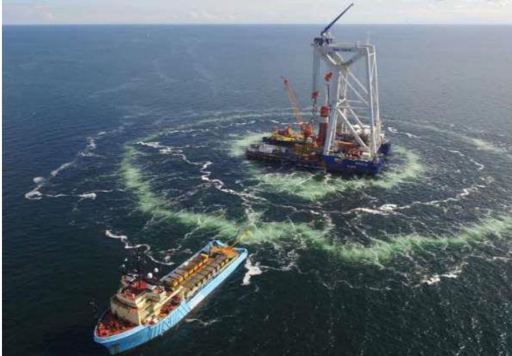
Abbildung 9 Doppelter Blasenvorhang im Einsatz
