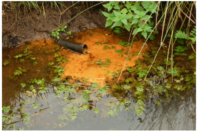
Abb. 12: Ausfällung von Eisenhydroxid (Verockerung) an einer Drainage (Foto: L. Rennebeck)
