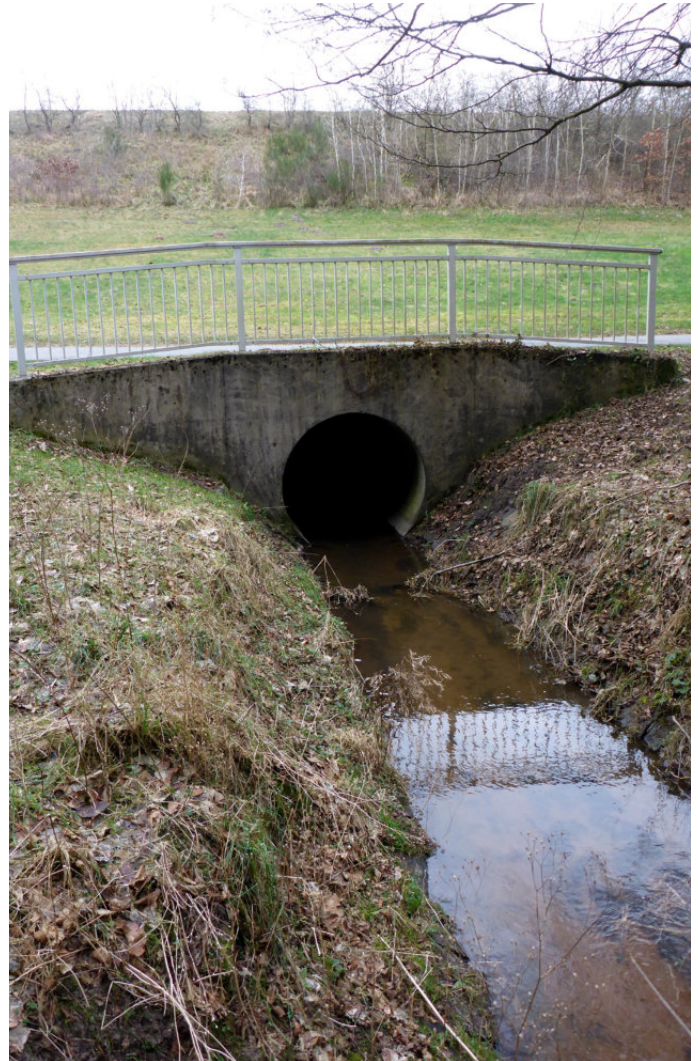
Abb. 7: Rohrdurchlass (Foto: LAVES)
