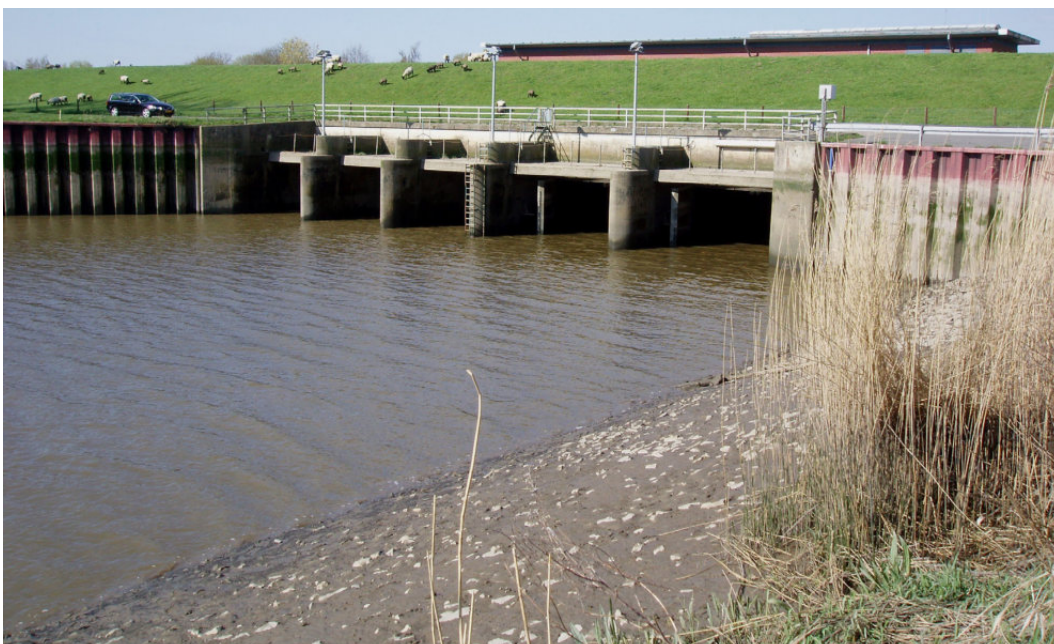
Abb. 10: Siel- und Schöpfwerk Strohausen (Foto: O.-D. Finch)
