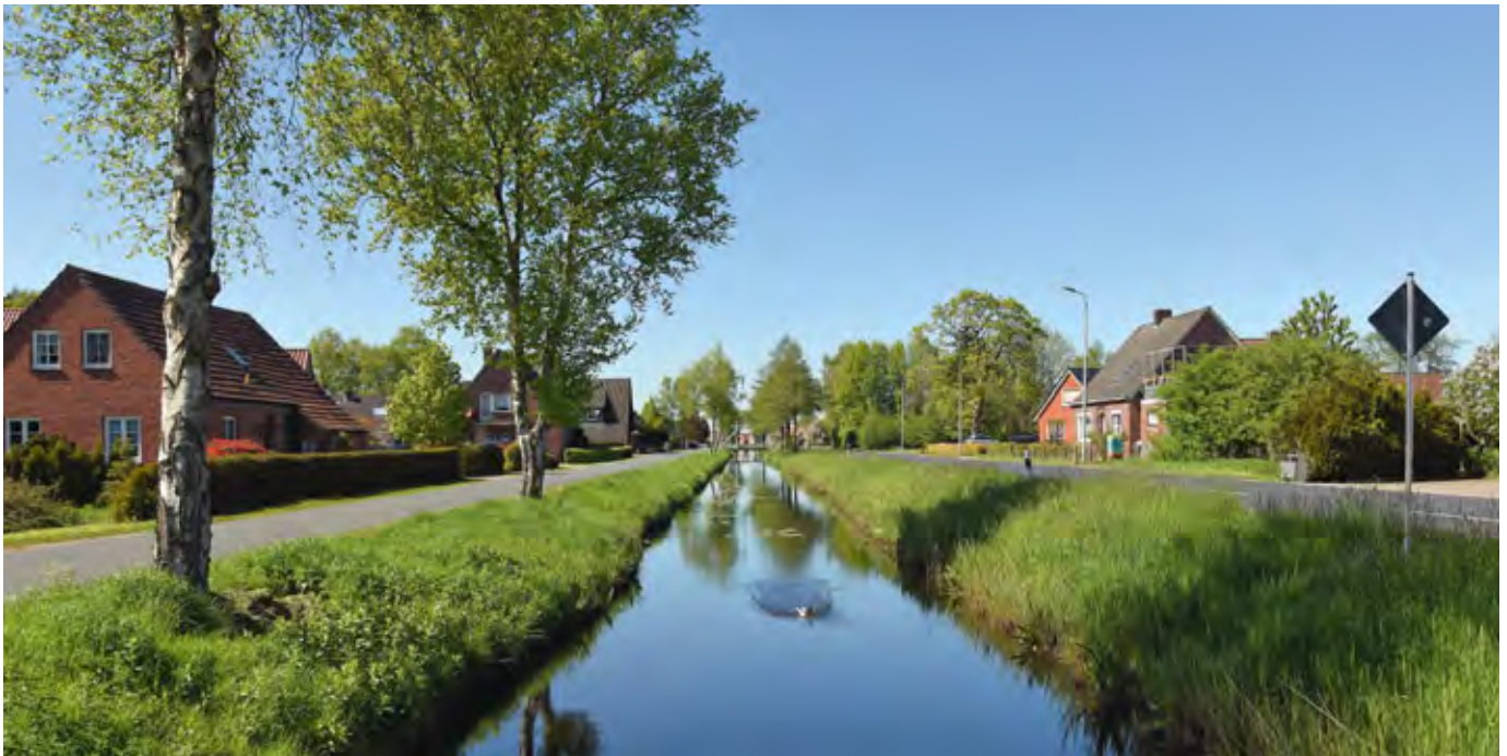
Jheringsfehn: Eine wenig überprägte Fehnsiedlung, in der sich die Bebauung an einem geradlinigen Netz von Kanälen und Straßen aufreicht. Der Haupterwerb bestand bis ins 19. Jh. im Verkauf des vor Ort abgebauten Hochmoortorfs, der über die Kanäle verschifft wurde. (Foto: H.-J. Zietz)
