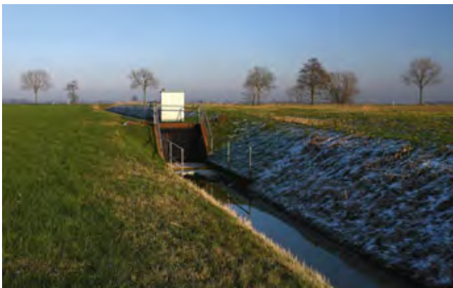
Grundlage für die Moorkolonisation: Eine effektive Entwässerung, die heute weiter zum Absacken des Bodens beiträgt. (Foto: H.-J. Zietz)
