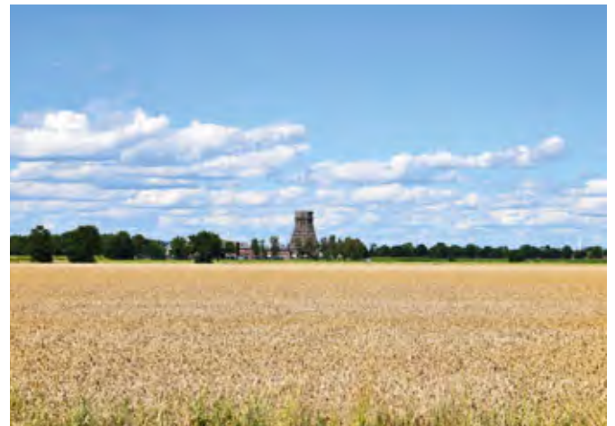
Kühlturm der ehemaligen SteinkohlENZECH E Lüdersfeld (Foto: C. Wiegand)
