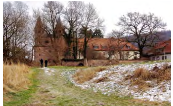
Die gesamte Klosteranlage ist im Wesentlichen aus Naturstein erbaut. (Foto: A. Harms)
