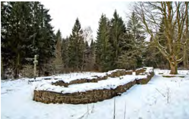
Die Fundamente der Winnefelder Kirche zeugen von den vielen Siedlungen, die im Mittelalter im Solling wüst fielen. (Foto: A. Harms)
