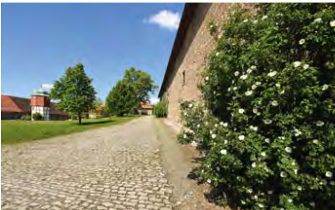
Alle Gebäude der Anlage sind aus Bruchsteinmauerwerk oder als Fachwerk errichtet, wie der Taubenturm links. (Foto: H.-J. Zietz)
