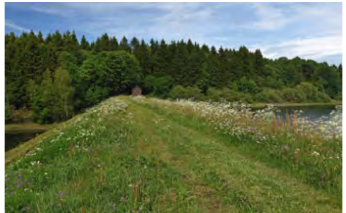
Ziel war es, das Wasser hoch zu halten und geringe Gefälle zu nutzen – hier zwischen Mittlerem und Unterem Pfauenteich. (Foto: H.-J. Zietz)
