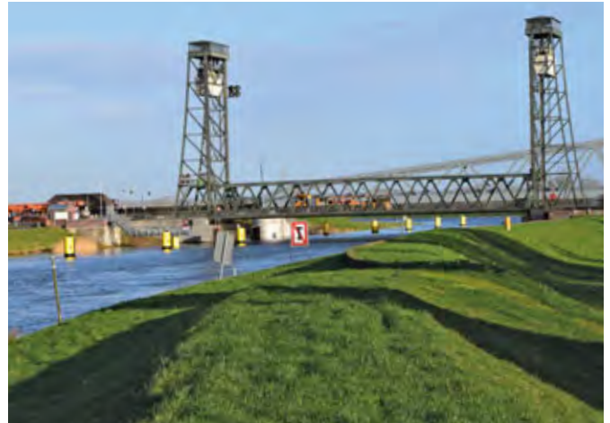
Deich und Hubbrücke über die Hunte in Huntebrück (Foto: C. Wiegand)
