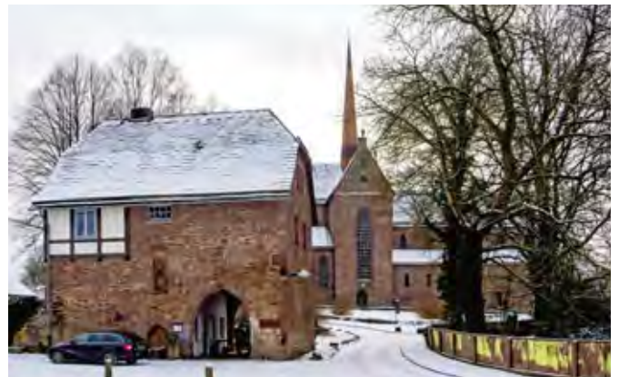
Das Kloster Amelungsborn ist nahezu vollständig aus Solling-Sandstein erbaut, der heute noch im Gebiet abgebaut wird. (Foto: A. Harms)
