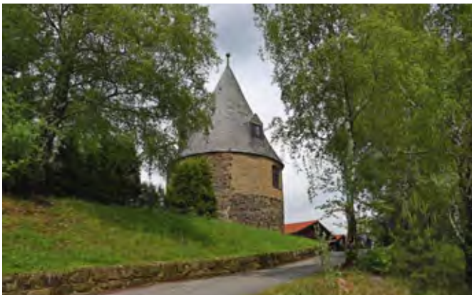
Der Maltermeisterturm aus dem 15. Jh. ist das älteste Tagesgebäude des deutschen Bergbaus. (Foto: H.-J. Zietz)
