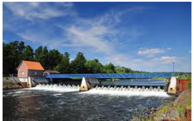
Das Wehr in der Aller auf Höhe der Hutweide (Foto: H.-J. Zietz)
