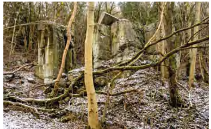
Gesprengte Bunkeranlagen im Wald im nordöstlichen Gebietsteil (Foto: A. Harms)
