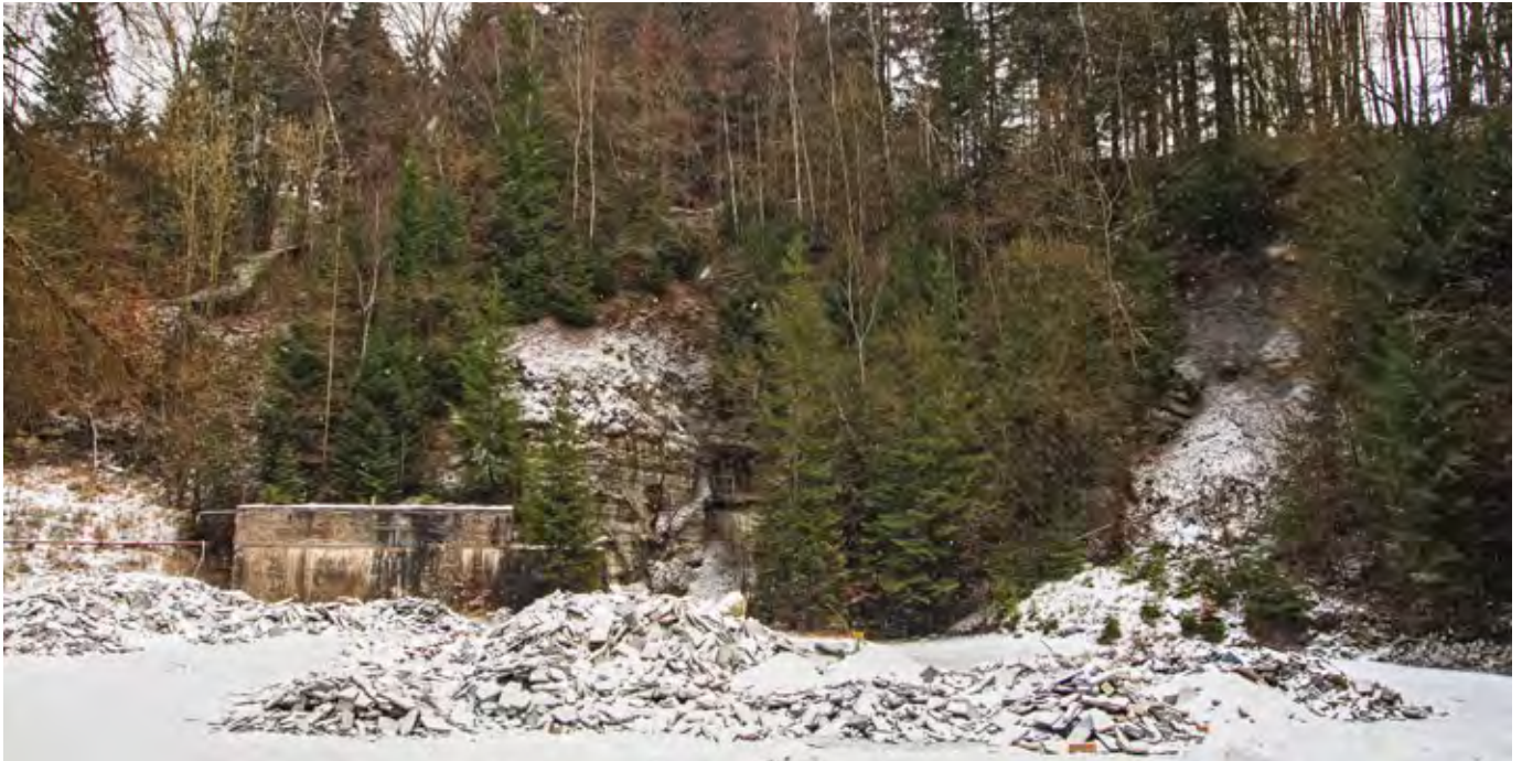
Eingang in einen Asphaltstollen (Foto: A. Harms)
