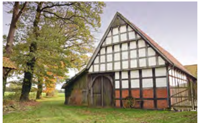
Für den Bau der Fachwerkgebäude wurden Hofeichen vorgehalten. (Foto: H.-J. Zietz)
