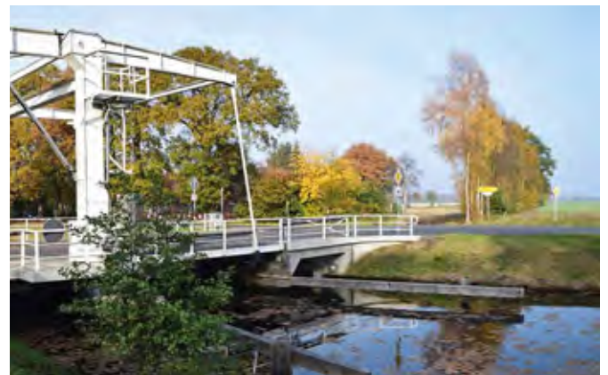
Klappbrücke an der Ramsloher Straße, rechts die Moorhufenflur (Foto: C. Wiegand)
