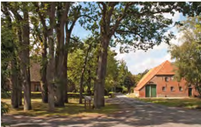
Im alten Ortskern von Reepsholt sind typische Gulfhäuser zu sehen. (Foto: A. Harms)
