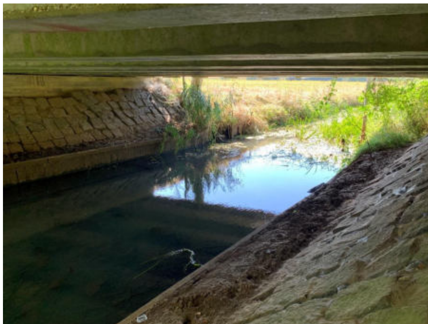
Abb. 19: Brücke unter der Straße am Dorfteich / Kassebruch; Laufweg unter MW-Niveau? (D1; Station 16+090; 08/2022)
