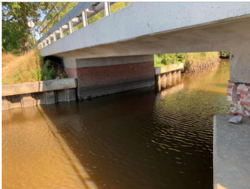
Abb. 22: Brücke unter der K50 - Neuenlander Straße (D2; Station 1+862; 08/2022); keine Berme
