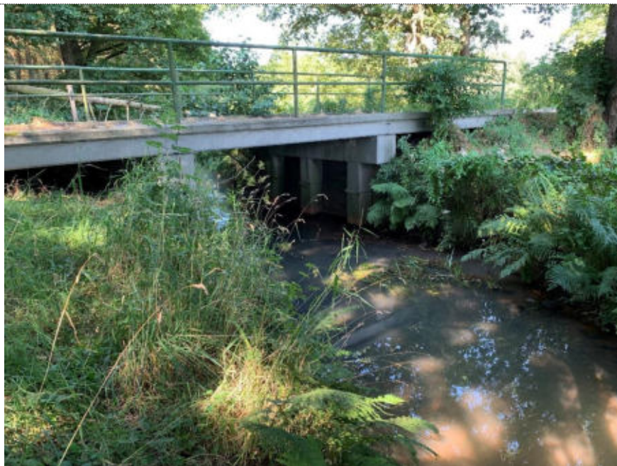
Abb. 18: Brücke unter dem Lehnstedter Weg (D6; Station 19+890; 08/2022); keine Berme
