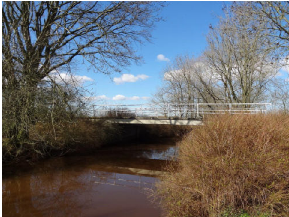
Abb. 16: Feldwegebrücke über die Gackau (Brücke „Gliesham“); Station 01+520; Bauwerksnummer D04 101
