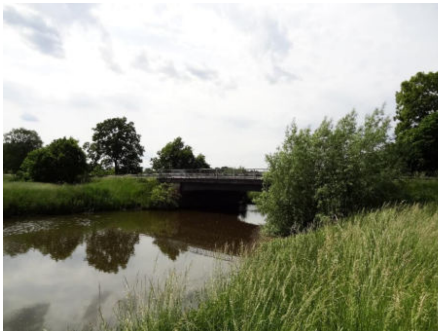
Abb. 23: Brücke Wulsdorfer Straße / Nesse (D12; Foto AGWA); keine Berme
