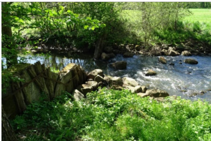
Abb. 24: Sohlgleite in der Lune; Station 26+14 - (Nr. S12 105 -Foto AGWA)
