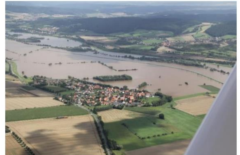
Hochwasserrückhaltebecken Salzderhelden Juli 2017
