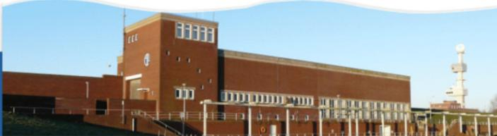
Neben 22 Unterschöpfwerken und dem Siel- und Schöpfwerk Greetsiel betreibt der Verband das Siel- und Schöpfwerk an der Knock, welches eine Förderleistung von 60.000 Liter pro Sekunde (4 Pumpen a 15.000 Liter/s) und zwei Sielläufe von je 11,5 m lichter Breite hat. Dieses Siel- und Schöpfwerk gehört damit zu den größten an der deutschen Nordseeküste.
