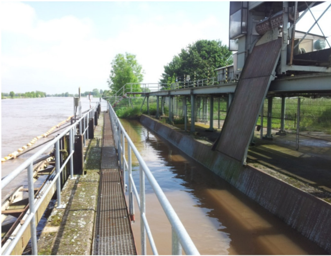
Abbildung 5: Kraftwerk Landesbergen: Kühlwasserentnahme, Grobrechenanlage (rechts), Quelle: Statkraft Markets GmbH
