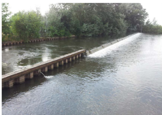
Abbildung 16: Kühlwasserrückgabe in den Hafen über das Streichwehr
