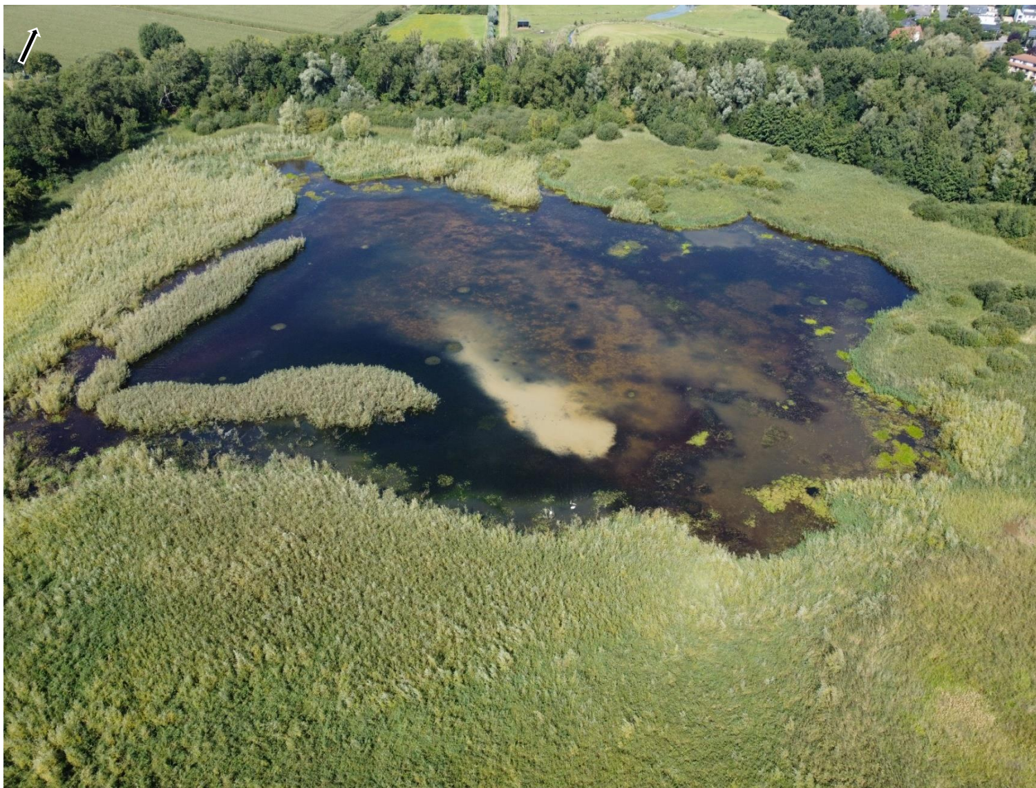
Abbildung 75: Nördliche Hälfte des Klärteiches 5.
