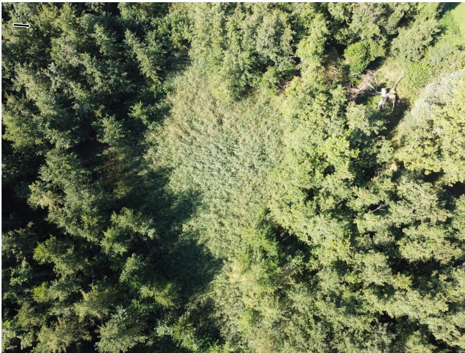
Abbildung 39: Westlicher Bereich des Klärteiches 6.
