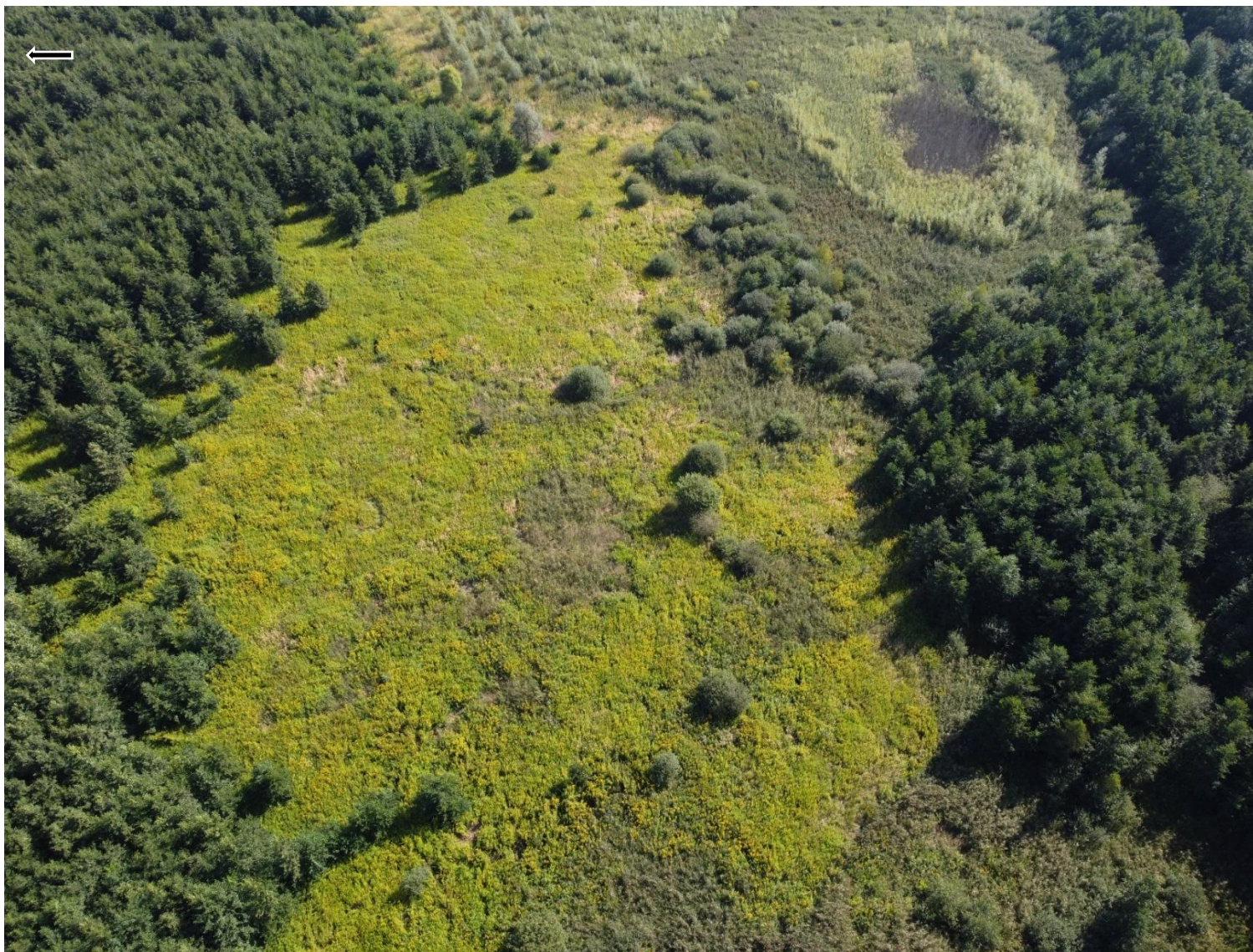
Abbildung 21: Mittlerer Bereich des Klärteiches 9.
