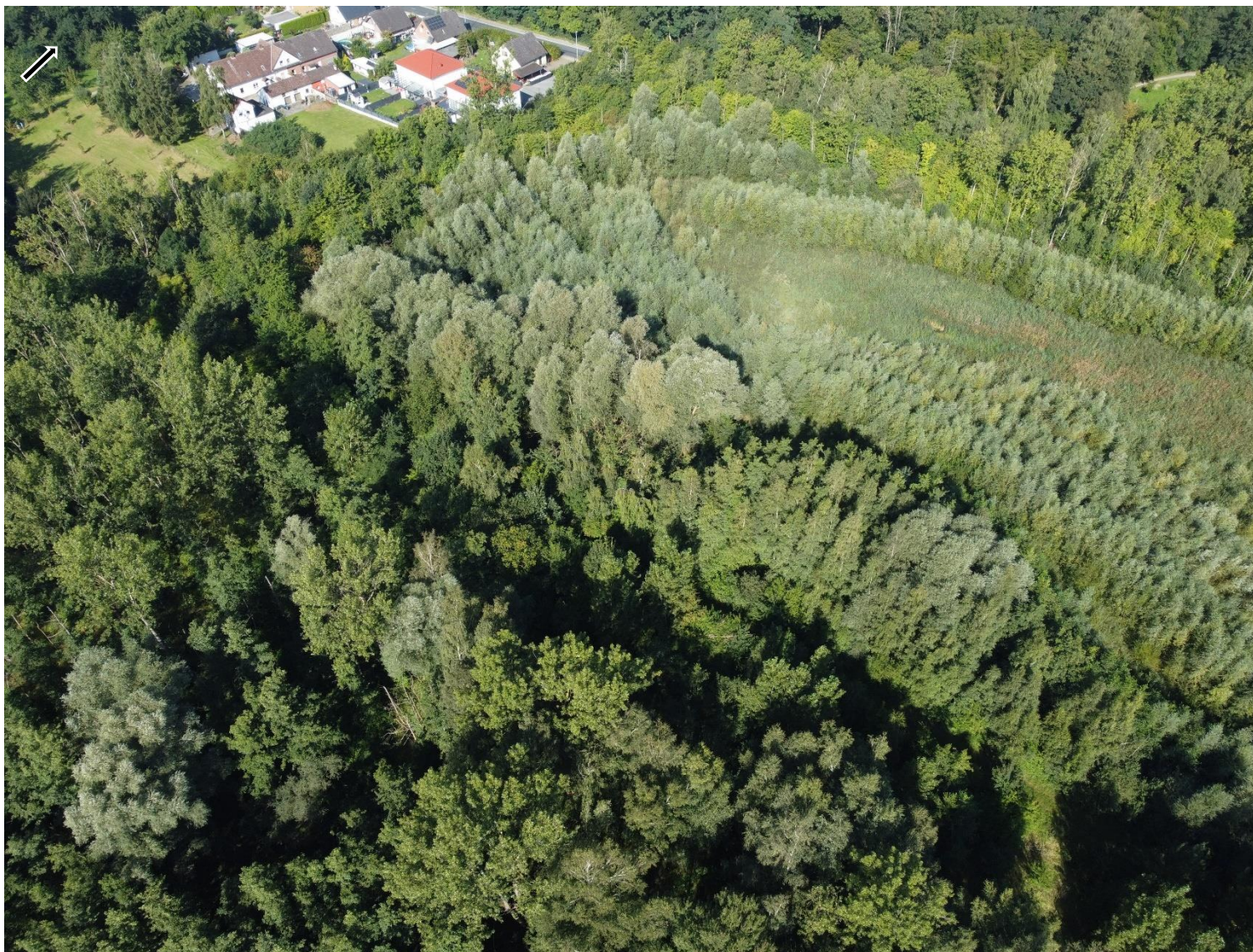
Abbildung 8: Südwestliche Hälfte des Klärteiches 13 sowie nordwestlicher Waldbereich des Klärteiches 7.
