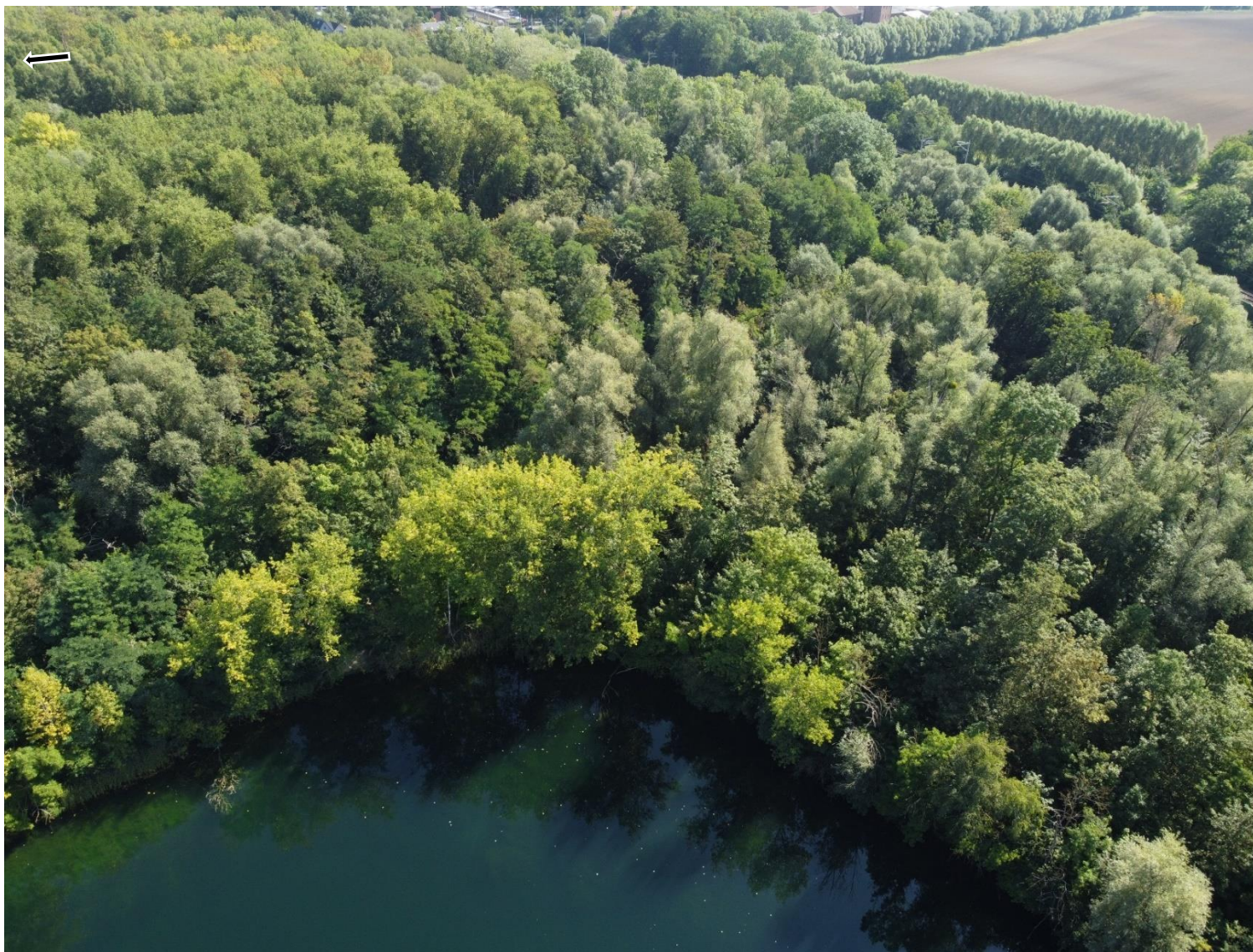
Abbildung 58: Südöstlicher Rand des Klärteiches 3 (ABU-Teich) und des südlichen Waldbereich des Klärteiches 2.
