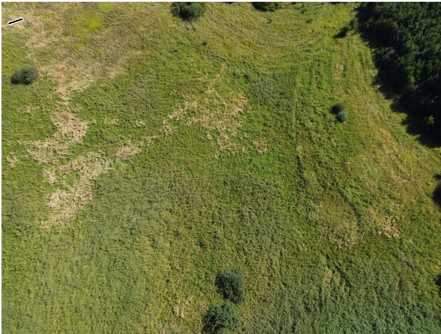
Abbildung 60: Südlicher Bereich des Klärteiches 4.
