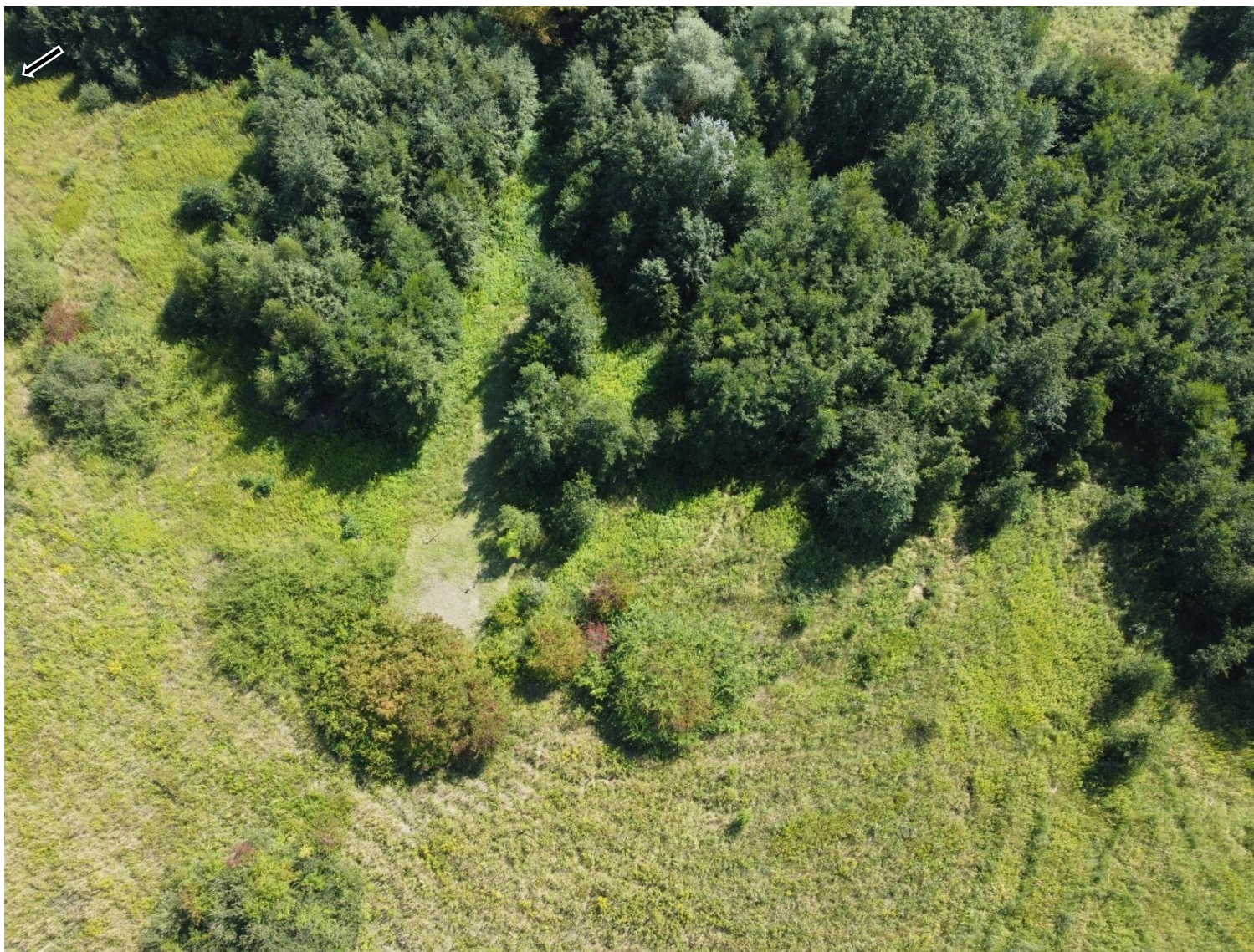
Abbildung 62: Südöstlicher Bereich des Klärteiches 4.
