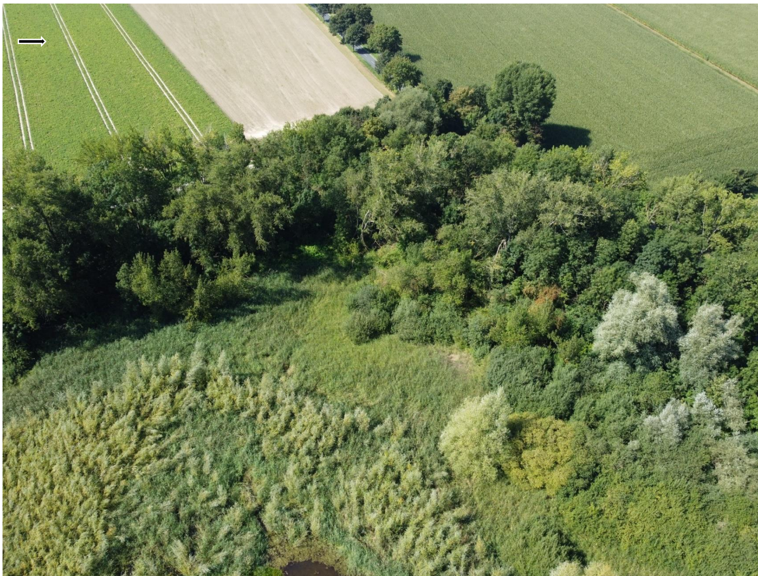
Abbildung 83: Nordwestlicher Rand des Klärteiches 5.
