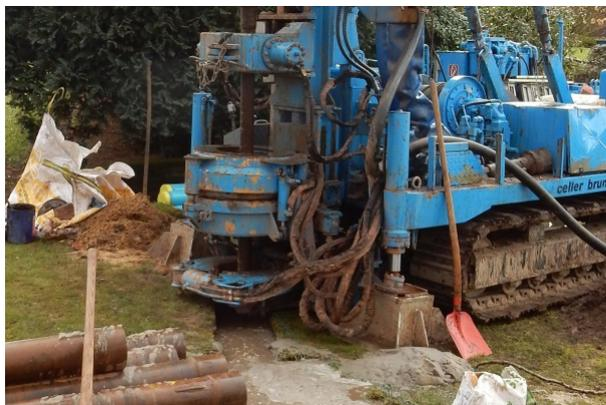
Abb. 32: Bohrung einer Grundwassermessstelle.
