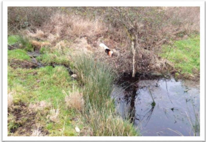
**Abbildung 1: Durchsickerung am Kösters Damm 12.2013 (das abgebildete Rohr ist ohne Funktion)**
