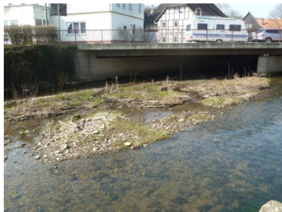
**Abb. 10:** Abgelagertes Geschiebematerial oberhalb eines Brückenbauwerks in der Ortslage Scharfoldendorf (Foto: UIH/Schackers)
