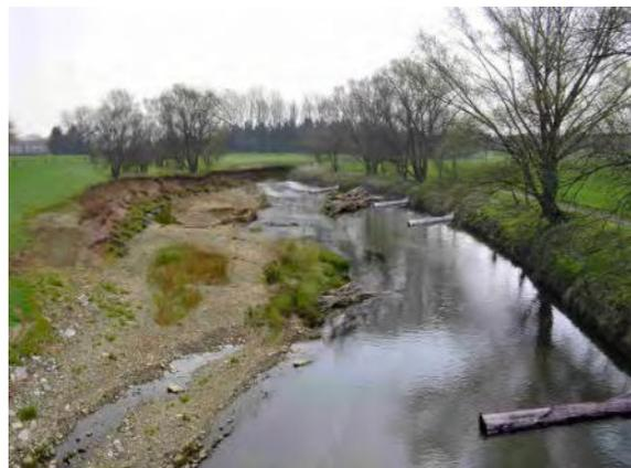
**Abb. 51: Totholz als Strömunglenker zur Initiierung einer eigendynamischen Entwicklung (Foto-
