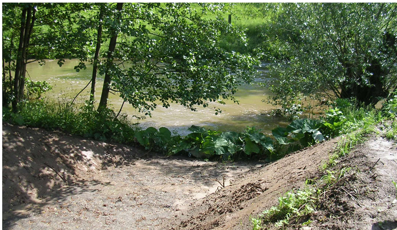
Dammöffnung im Jahr 2007 zur Durchströmung des Auwalds bei Hochwasser
