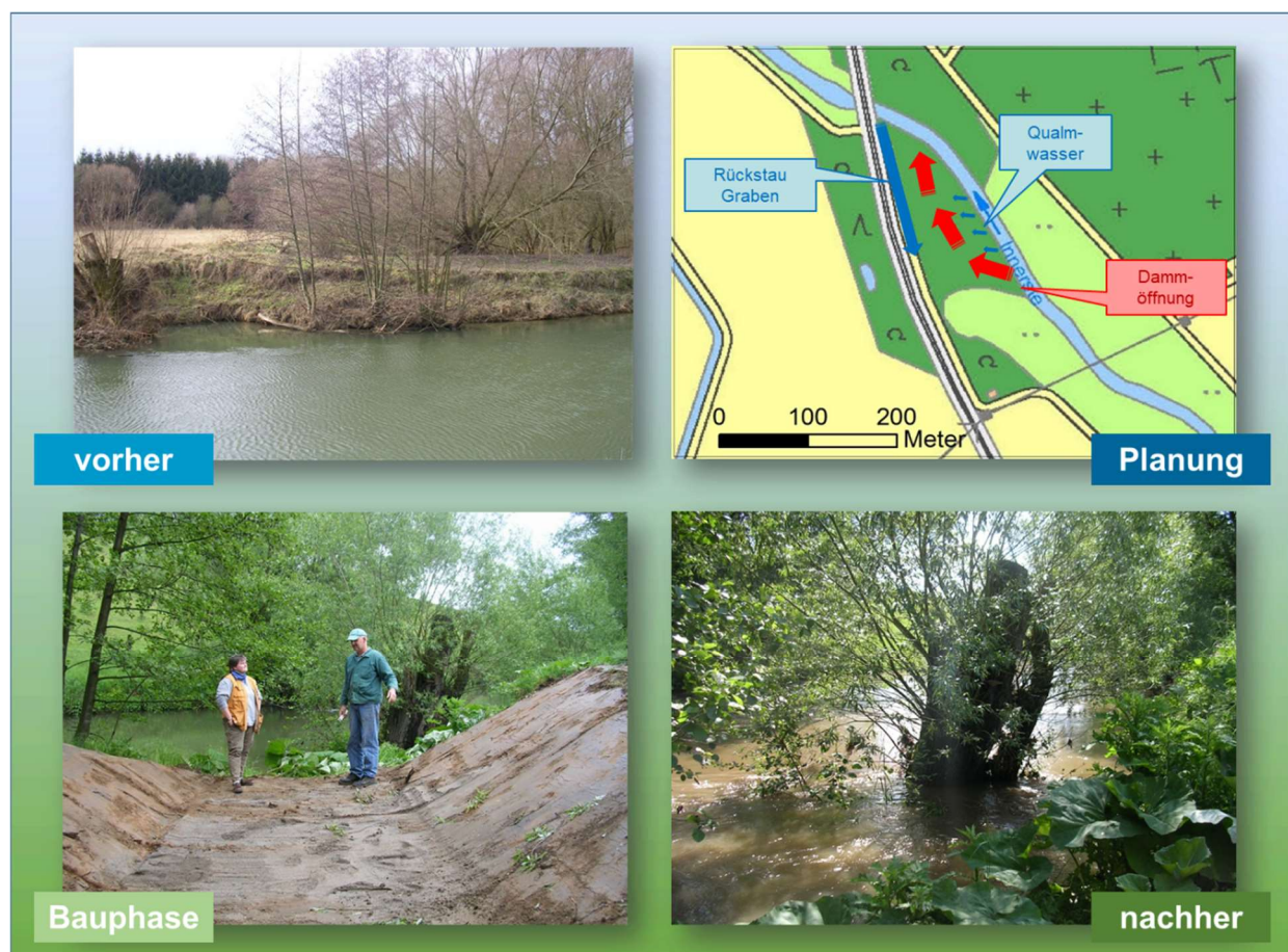
Abb. 6: Öffnung des Damms oberhalb des Auwalds im Jahr 2007
