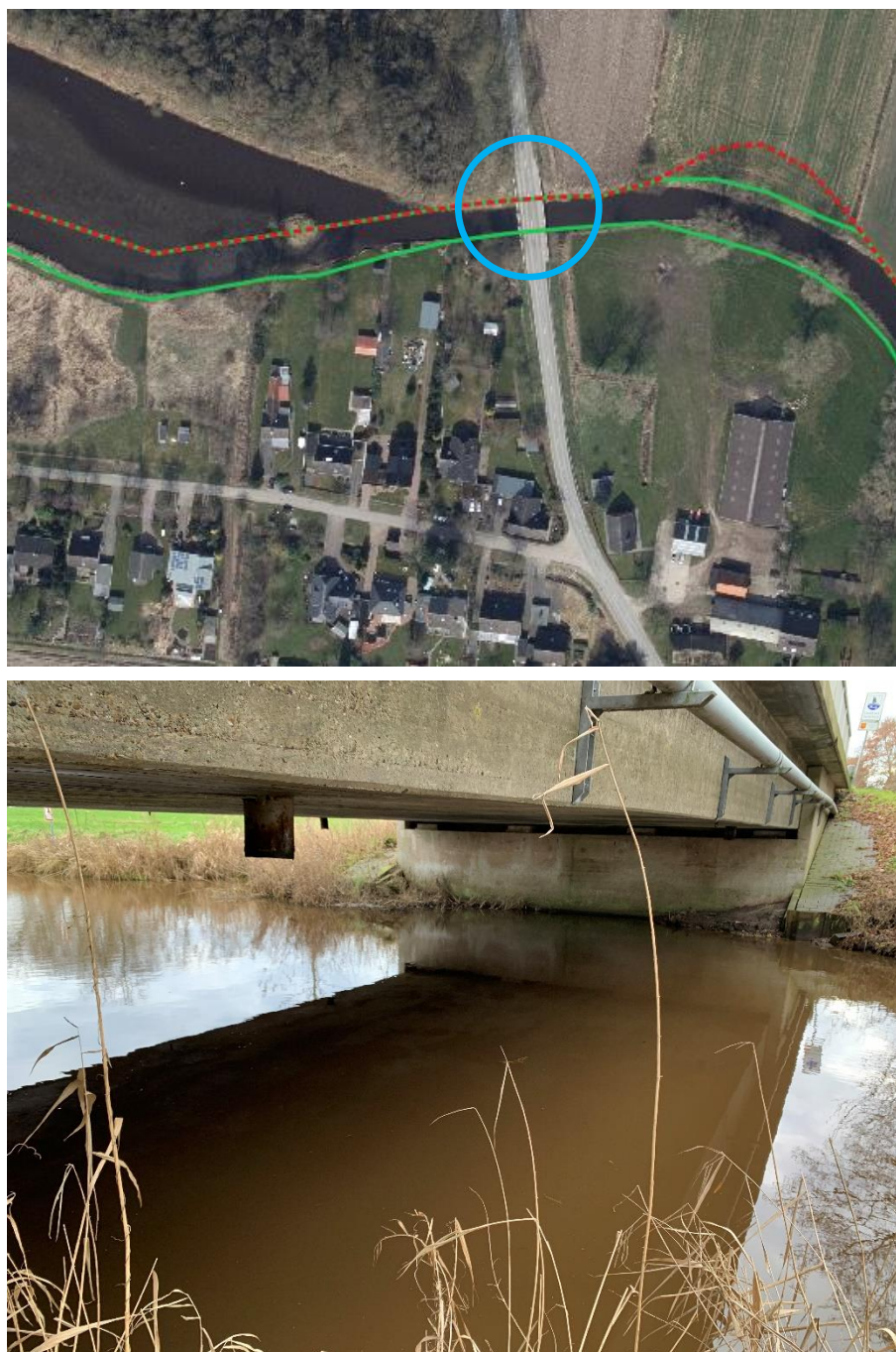
Abb. 12: Straßenbrücke über den Aschwardener Flutgraben nördlich von Aschwarden Luftbild: Standort des Fotos (Dezember 2022): blauer Kreis; rot: Kreisgrenze; grün: Grenze des FFH-Gebietes 187
