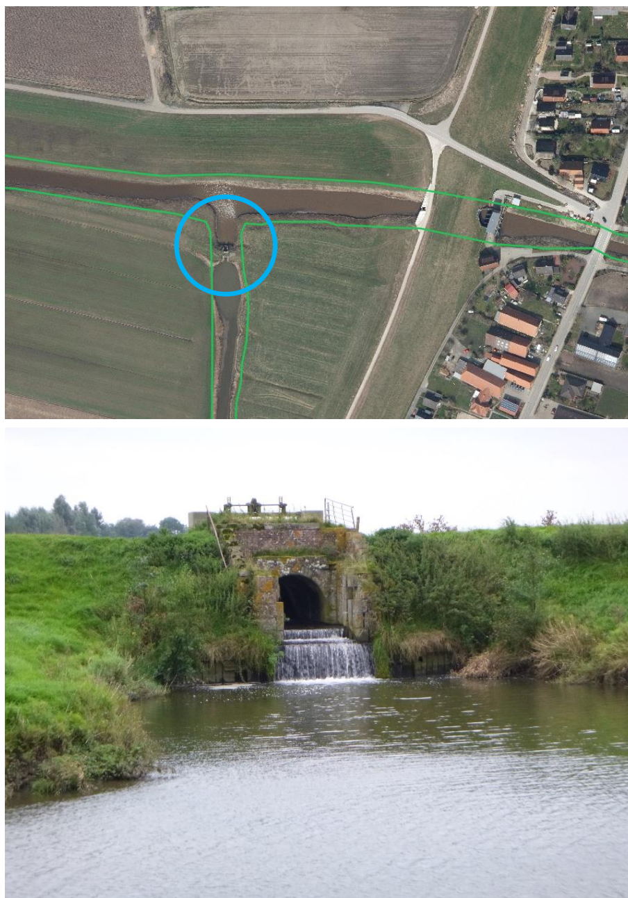
Abb. 14: Durchlass für die Alte Weser zum Hinnebecker Fleth (Blick von Norden) Luftbild: Standort des Fotos (C. Habenicht; September 2021): blauer Kreis; grün: Grenze des FFH-Gebietes 187
