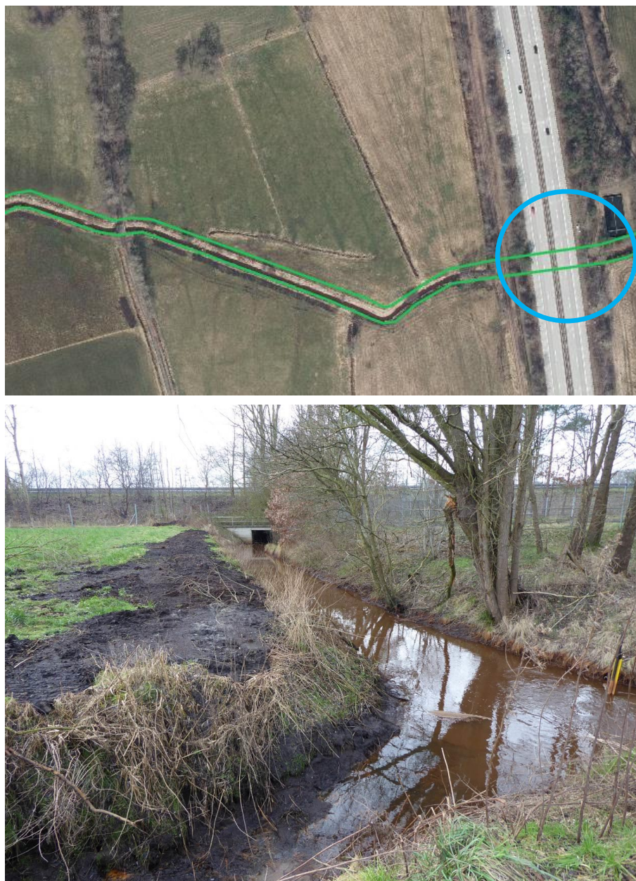
Abb. 20: Garlstedter Abzugsgraben östlich der Autobahn mit der Unterführung unter der BAB A27
