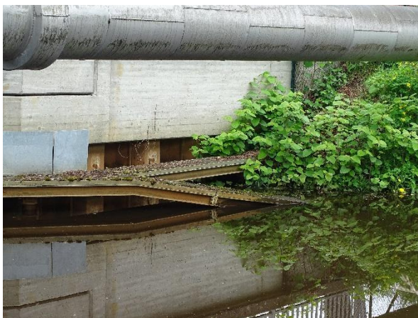
Abbildung 9: In Lienthal bestehen bei der Brückenunterführung der Hauptstraße mehrere Stege, die den Fischotter unter der Brücke hindurch leiten sollen (17.05.2021, NEUMANN)
