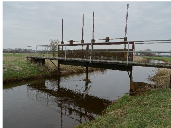
Abbildung 6: Nördlich der Heidberger Straße wird das Wehr an bis zu fünf Tagen hintereinander geschlossen, um die Wörpe für Mäharbeiten aufzustauen (25.03.2021, NEUMANN)
