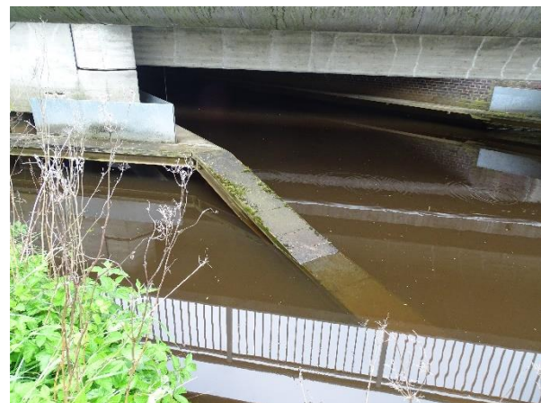
Abbildung 10: Direkt aus dem Wasser führt der Steg den Fischotter unter der Hauptstraße in Lienthal durch (17.05.2021, NEUMANN)
