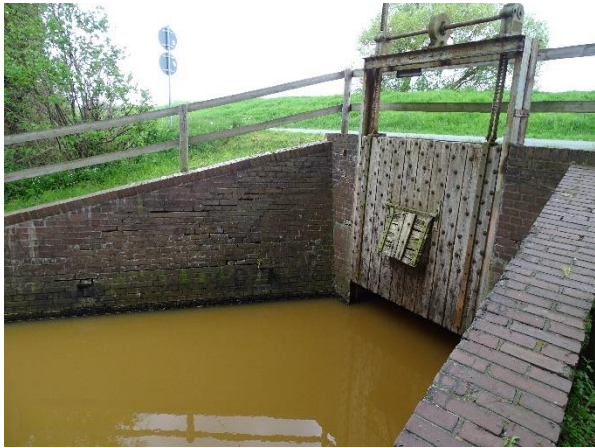
Abbildung 3: Das Sieltor am Truper Sielfleet wird manuell geöffnet. Es stellt geschlossen ein Wanderhindernis für Fische, Rundmäuler und den Fischotter zur Wümme dar (17.05.2021, NEUMANN)
