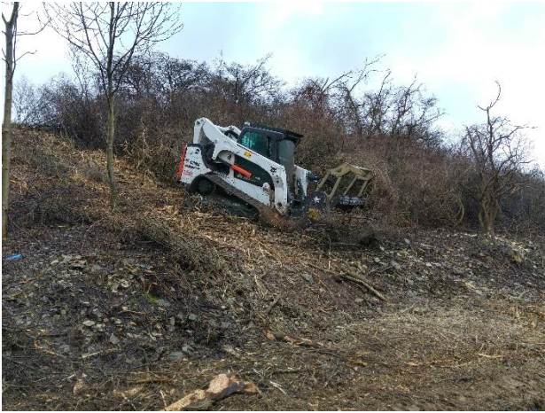
Foto 43: Bobcat-Forstmulcher beseitigt Gebüschriegel auf Flst. 25/2 (20.02.2017)
