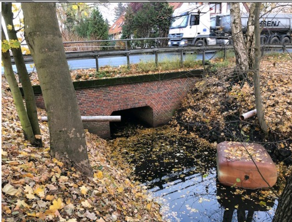
Anlage 2: Beispiel für erforderliche Aufweitung eines Durchlasses mit Berme, hier in Mittelbauer unter K8 auf Höhe mehrerer Totfunde des Fischotters (Foto Frank Bachmann)
