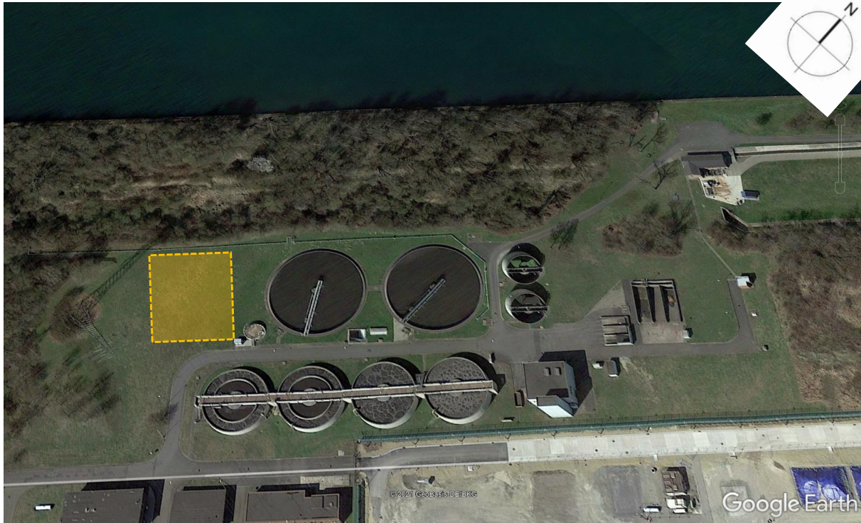
Abbildung 2.2: Satellitenaufnahme der Werkskläranlage der SZFG; gelb: Vorgesehenes Baufeld für die 4. Reinigungsstufe (Quelle: Google Earth Pro, Ohne Maßstab, Systemskizze)
