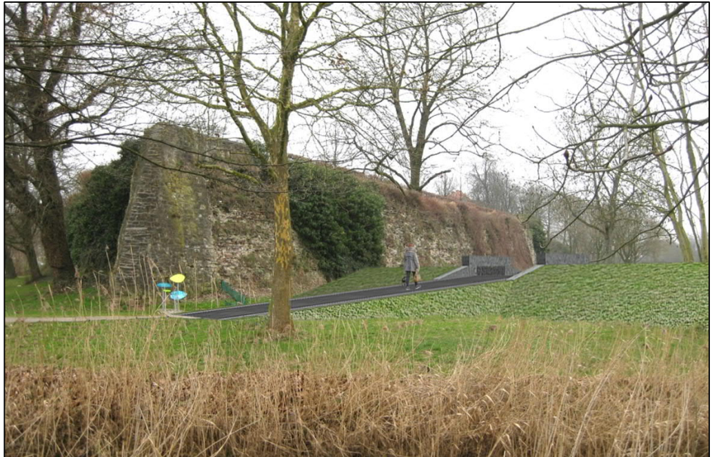
Abb. 2.2: Fotomontage des Deichtores mit Anrampung und des Deichanschlusses an die historische Festungsmauer
