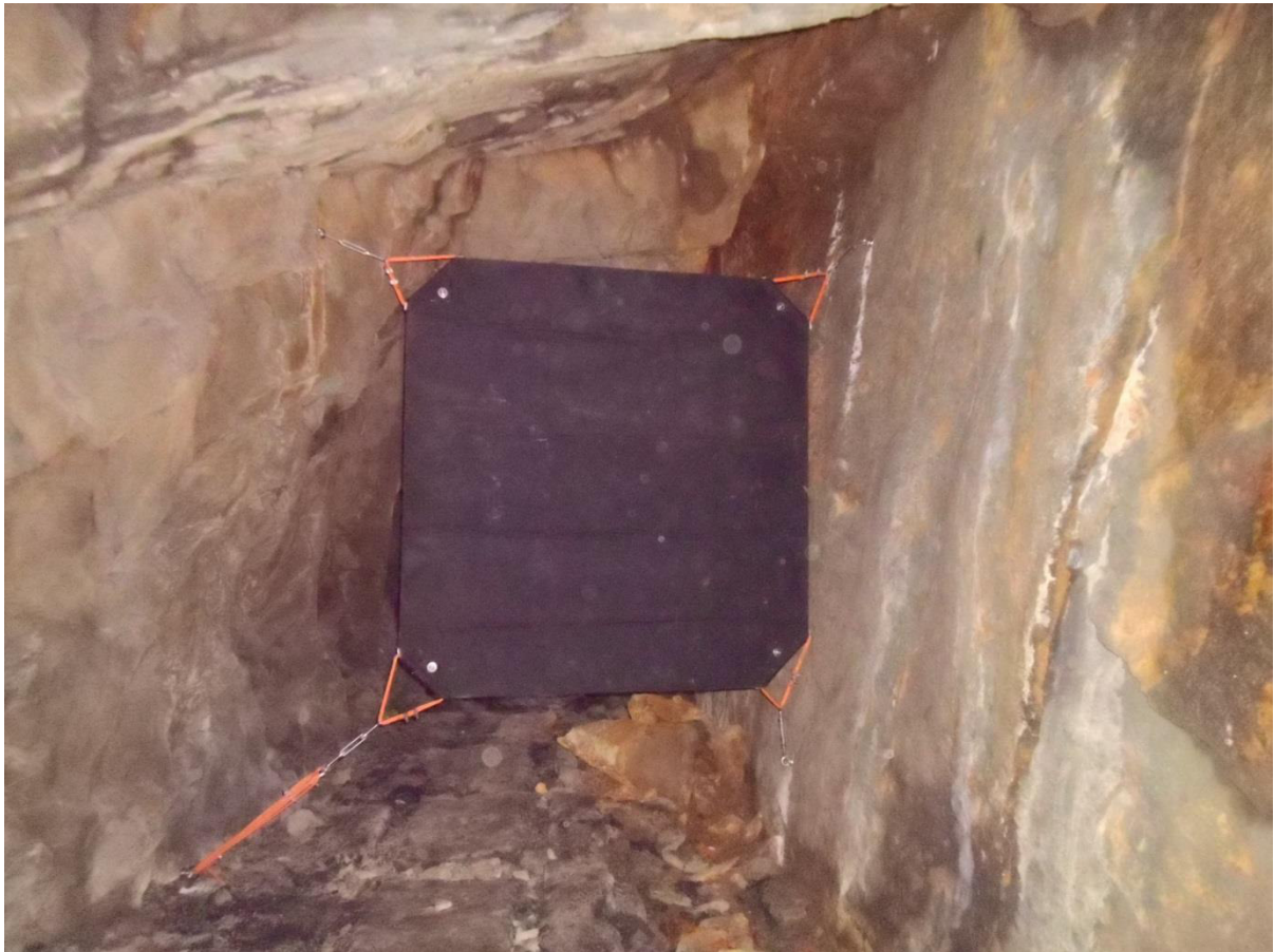
Anhang 1: Im Stollen nahe der zweiten Mundlochöffnung zum Steinbruch gespannte Kunststoffmatte zur Reduzierung des Lichteinfalls und damit Optimierung der Hangplatzeignung des dahinter liegenden Stollenabschnitts
