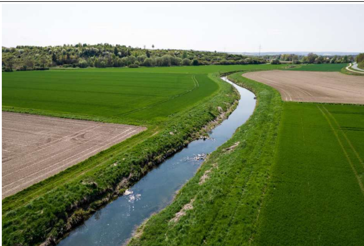
Foto 13 Unterlauf der Ilme östlich von Einbeck. Der Einbau von Strömungslenkern soll den sonst stark begradigten und monotonen Abschnitt der Ilme gewässermorphologisch aufwerten und eine erhöhte Fließdynamik bewirken.
