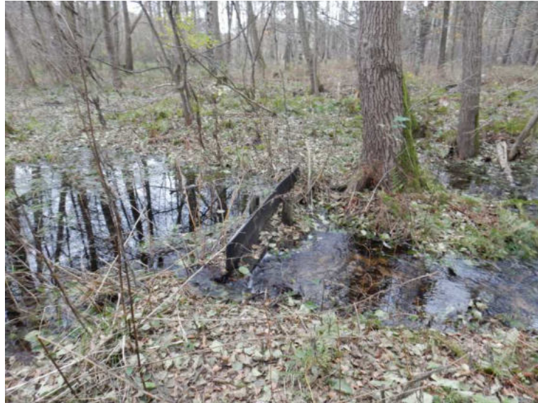
Abbildung 21: Kleiner Stau am nördlichen Ende der im Süden gelegenen Teichkette; der Stau wird umspült
