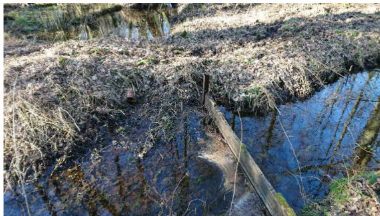
Abbildung 22: kleiner, mutmaßlich illegal gebauter Stau im nördlichen Teil des Grenzgrabens
