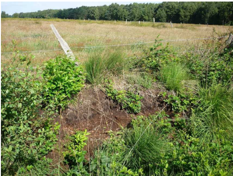
Tief einschneidender, stark bewachsener Graben (Wegeseitengraben) zwischen Flurstücke und Feld-/Grasweg.
