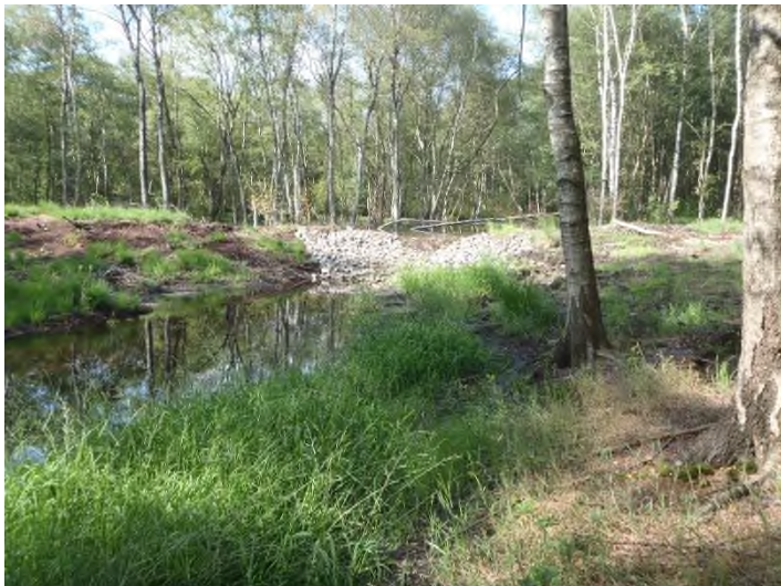
Abb. 3: Wasserrückhaltung durch Querdamm der den Talraum auf ca. 80 m absperrt (Foto: GRONTMIJ GMBH 2012)
