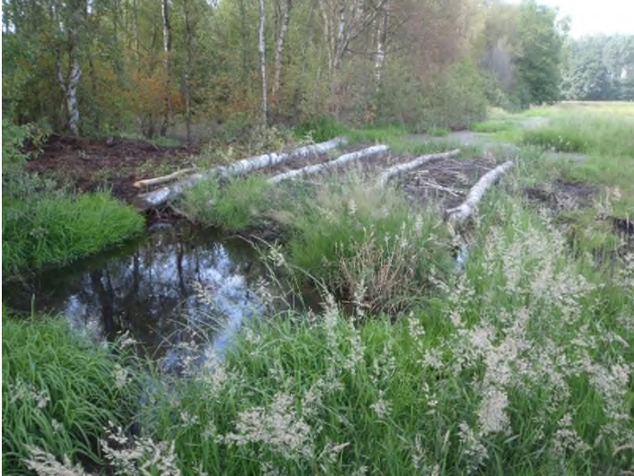
Abb. 4: Überlaufdammbauwerk im Gewässerprofil (Foto: GRONTMIJ GMBH 2012).
