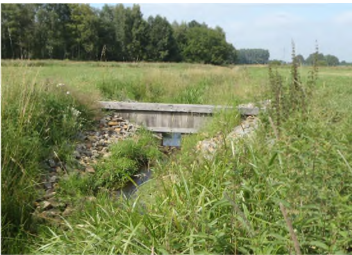
Abb. 5: Drosselbauwerk zur Abflussminderung bei Hochwasserereignissen (Foto: GRONTMIJ GMBH 2012).
