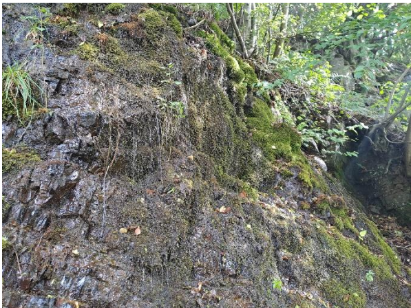
Abb. 3: überrieselter Felswandbereich im Süden.
