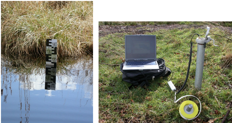
Abb. 16: Wasserstandmesseinrichtungen für ein hydrologisches Messnetz.
