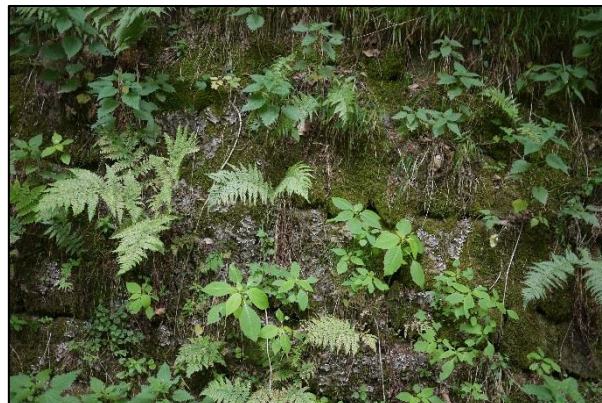
Abb. 63: Ausbreitung von Störzeigern in den Mauerfugen (Abt. 2030, PoNr. 603)
