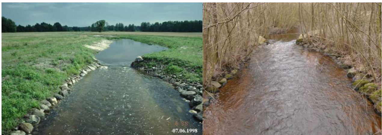
Abbildung 4: Renaturierungsmaßnahmen an der Meiße: 1998 hergestellte Umgehungsrinne um das im alten Meißeabschnitt befindliche Wehr. Links Aufnahme vom 07.06.1998, Rechts Aufnahme vom 03.04.2017. Quelle: Reinhard Altmüller
