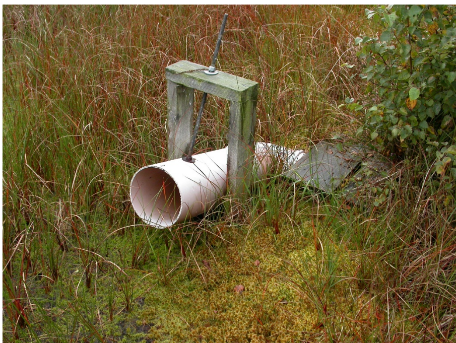
Abb. 18: Regulierbare Staupunkte mit verstellbaren Winkeln und Rohrdurchlässen.
