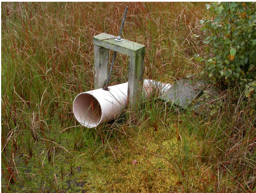
Abb. 20: Regulierbare Staupunkte mit verstellbaren Winkeln und Rohrdurchlässen.
