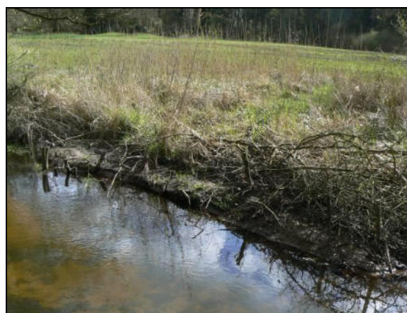
Abb. 11: Uferbefestigungen an der Este in Abt. 318
