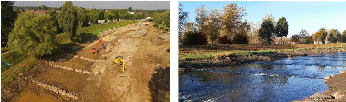
Abb. 10: Rückbau des Wehres in Schüttorf und Errichtung eines Raugerinnes im Jahr 2021 (Quelle: NLWKN)
