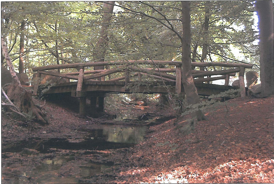
Bild 5: Halsebach: ausreichendes Lichtraumprofil und weitestgehend naturnahes Gewässerprofil mit Bermen unterhalb der Holzbrücken im Sachsenhain. Foto: Büthe
