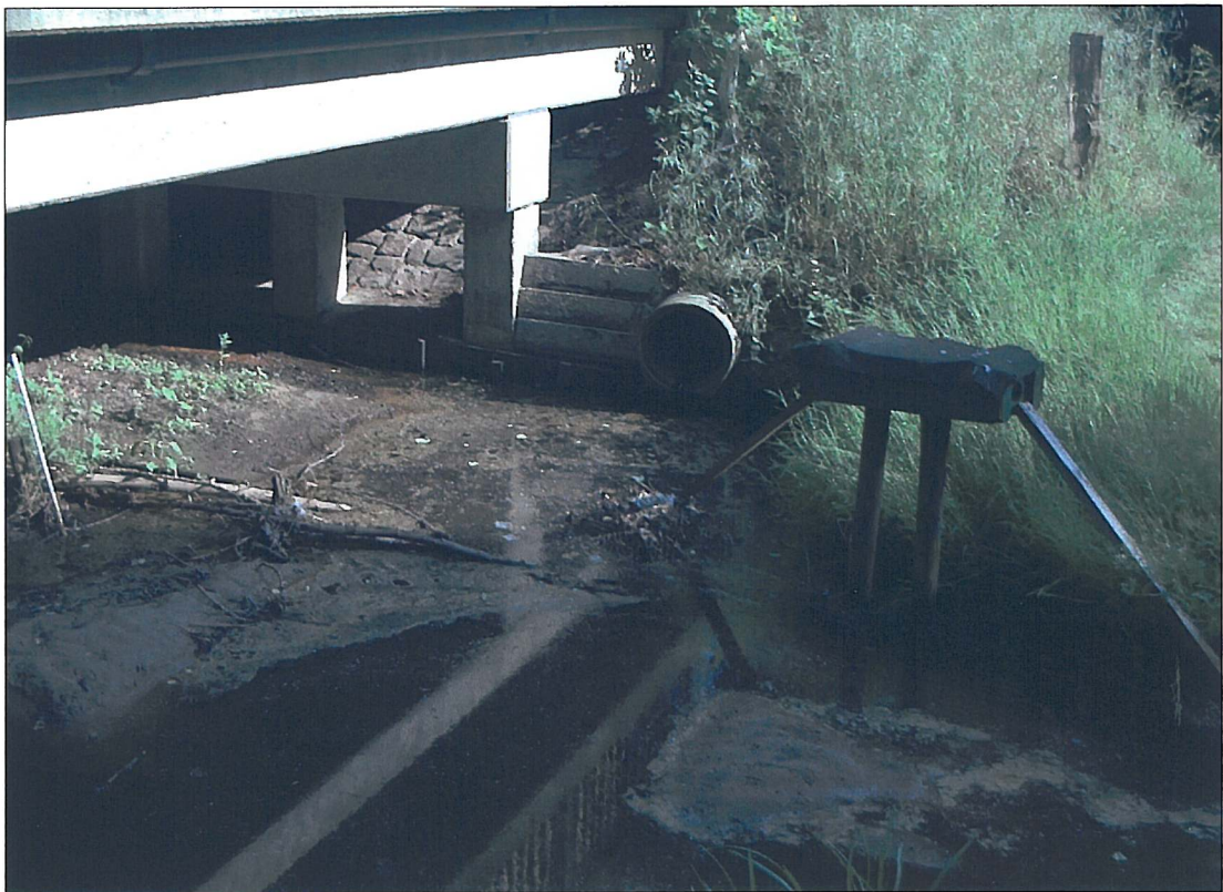
Bild 10: Halsebach: Regenwassereinleitung an der B215. Hohe Feinstsedimentauflage im Bereich der Brücke.
