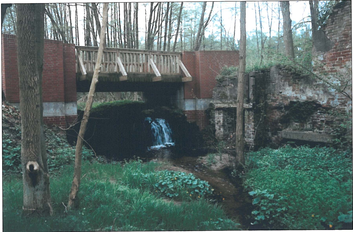
Bild 17: Halsebach: Ehemalige Mühlenstau Neumühlen. Die Absturzhöhe beträgt zurzeit rd. 1,4 m (früher rd. 2,4 m).
