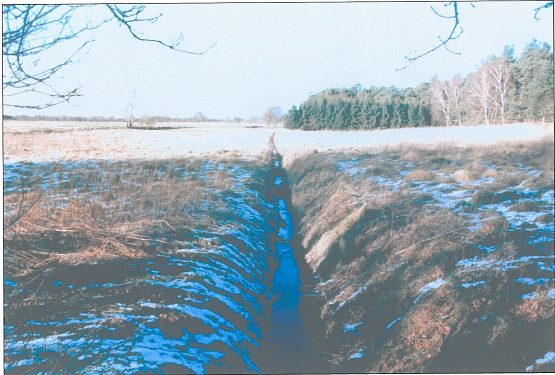
Bild 33: Halsebach: Einfaches Trapez (Grabenprofil) (Februar 2002).
