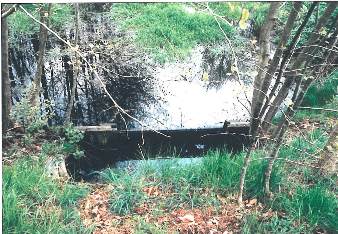
Bild 25: Halsebach: Der Holzstau in Scharnhorst dient zum Aufstau und zum Wasserrückhalt. Oberhalb stellen sich Stillwasserverhältnisse ein.
