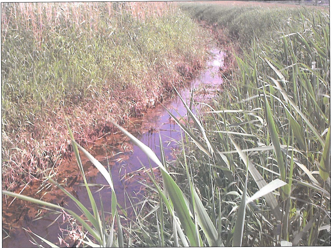
Bild 3: Halsebach: ausgebautes, einfaches Trapezprofil mit teilw. Verwallung zum Grünland.
