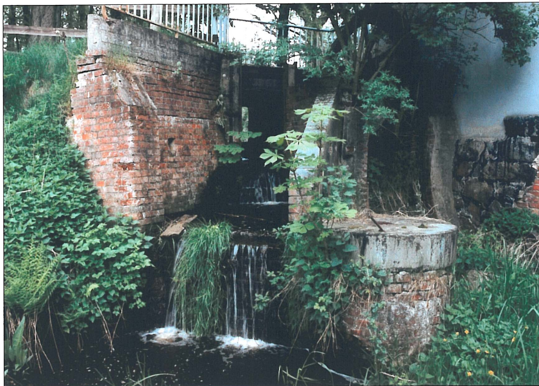
Bild 24: Halsebach: Mühlenstau der Wassermühle Dovemühlen. Die aquatische Passierbarkeit ist hier nicht gewährleistet.
