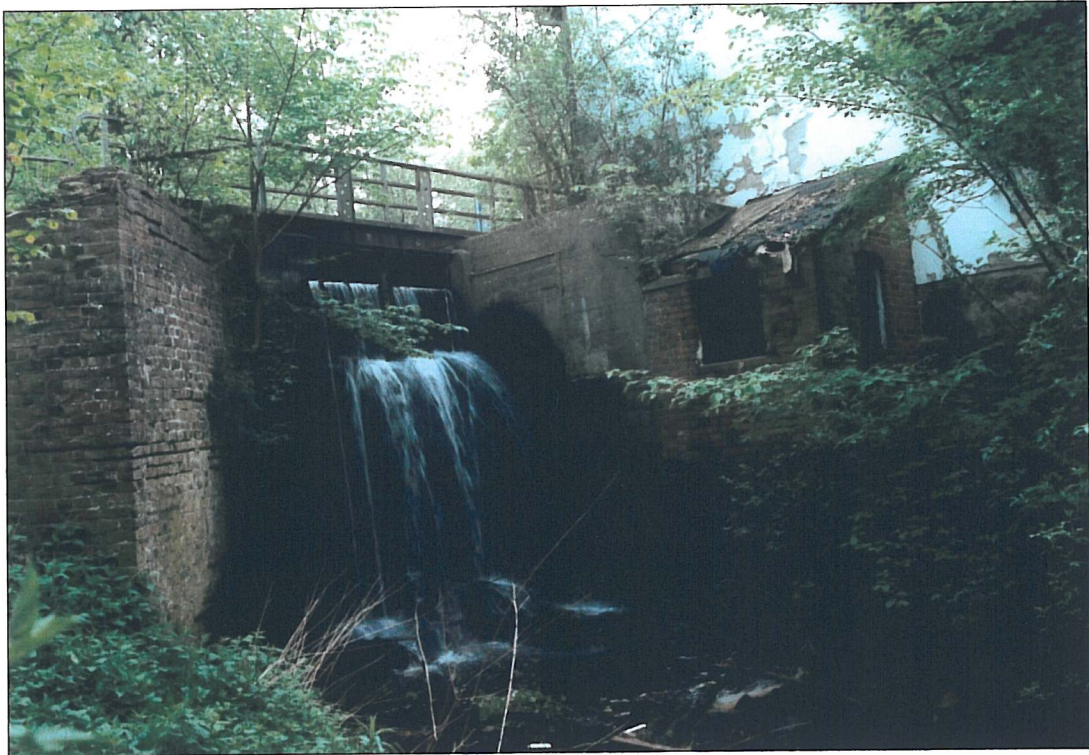
Bild 7: Halsebach: Das Wehr Halsemühle dient zum Aufstau des Mühlenteiches und unterbindet die aquatische Passierbarkeit. Die Wasserspiegeldifferenz vom Mühlenteich zum Unterwasser beträgt rd. 4,00 m. Foto: Bütke
