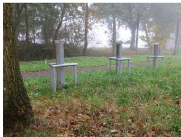
Abb. 3-4: Grundwassermessstellen – Ausbau in drei Filtertiefen (Foto NLWKN Bst. Aurich)
