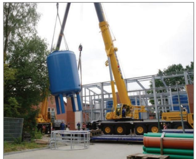
Abb. 7-10: Neubau der Aktivkohlefilteranlage – Einbau der Filterkessel (Foto WVV Rheiderland)
