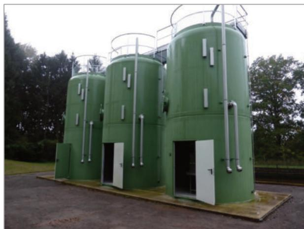
Abb. 7-15: Wasserwerk Hoya – Filterkessel der Aktivkohleanlage (Foto SG Grafschaft Hoya)
