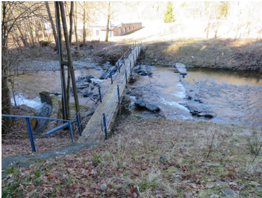
Abb. 31: Aufgelöste Sohlgleite an der Brücke in Höhe der Wasserkraftanlage.
