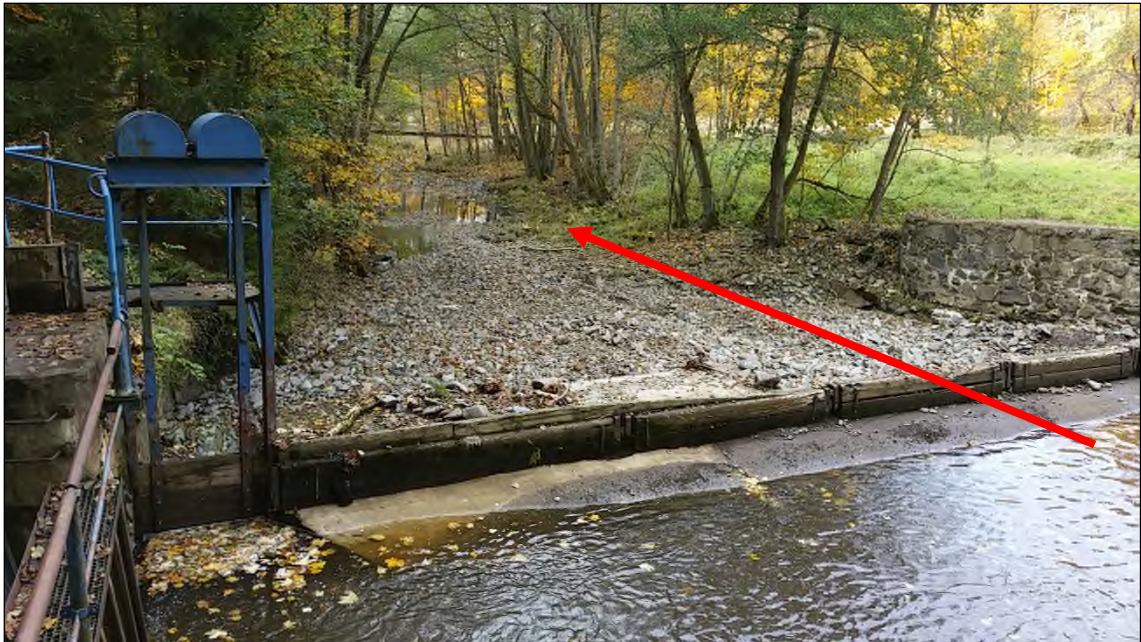
Abbildung 11: Alternative 2 - Fischaufstiegsanlage im vorhandenen Gewässer
