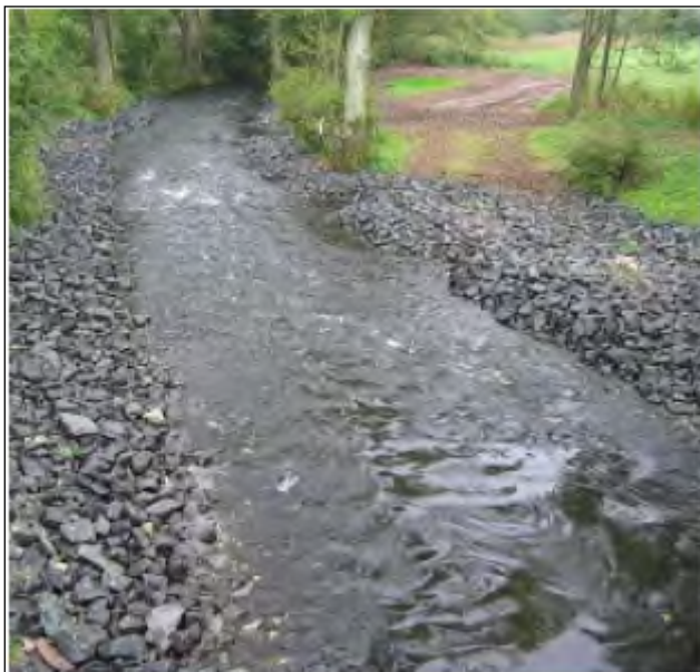
Abbildung 12: Beispiel Raugerinne ohne Einbauten [DWA-M 509]
