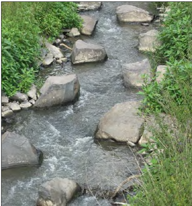
Abbildung 13: Beispiel Raugerinne mit Störsteinen [DWA-M 509]
