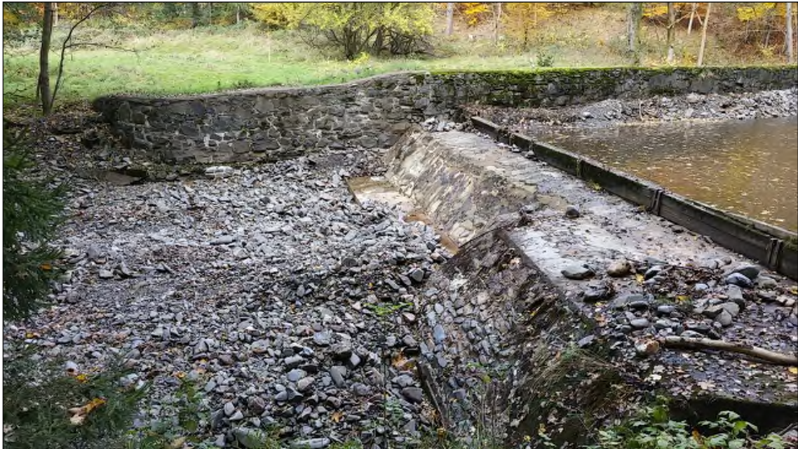
Abbildung 8: Bestehendes Wehr Sieber IV [ipp, 2016]
