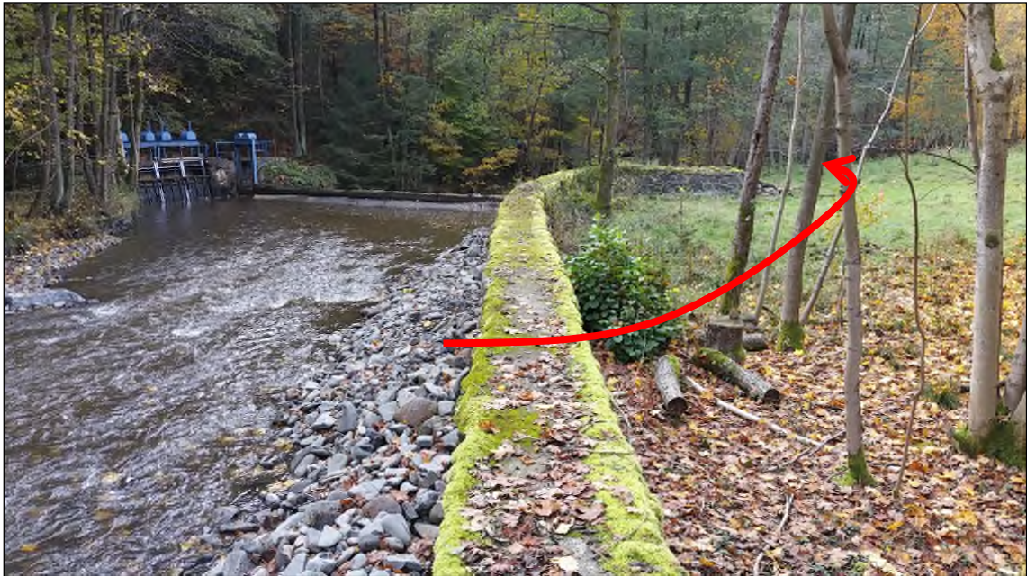
Abbildung 10: Alternative 1 - Fischaufstiegsanlage als Umgehungsgerinne
