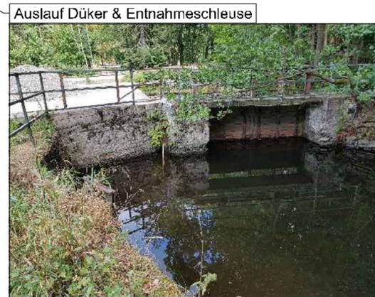
Auslauf Düker & Entnahmesleuse
