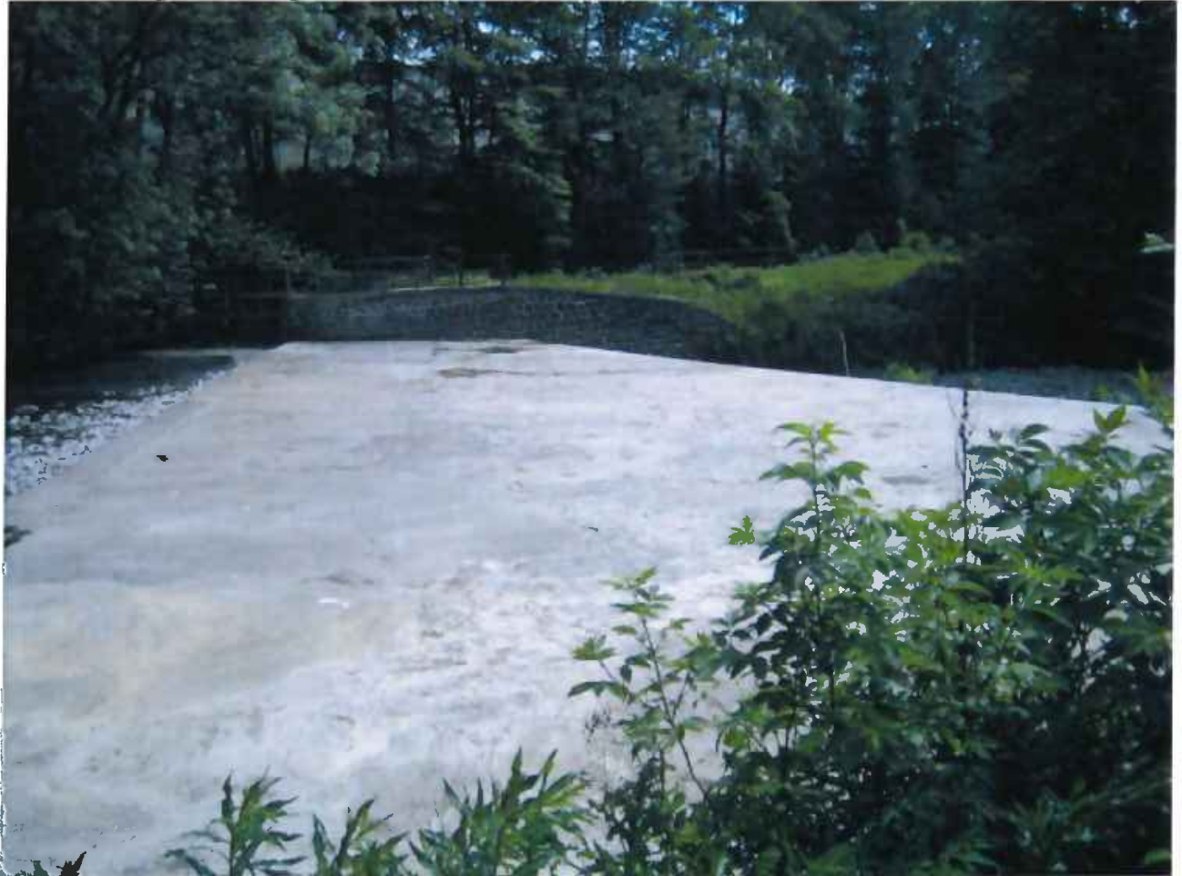
Bild Nr. 12 – Betonplatte von Wehr V in der Sieber unter der der Düker liegt. Blick von der mittleren Wehrwange auf die Ausleitung des Betriebsgrabens zu Smurfit Kappa.
