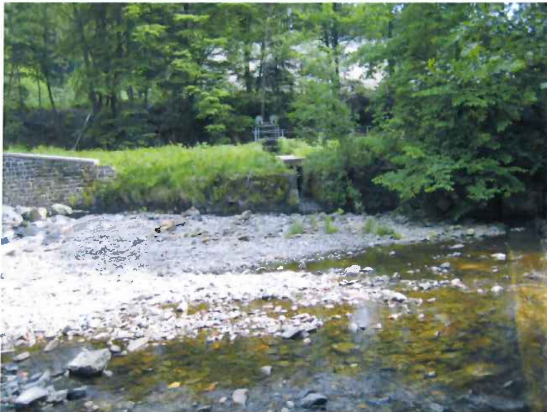
Bild Nr. 17 – Blick von der mittleren Wehrwange auf das untere Teilstück der östlichen Wehrwange mit dem ersten Fehlschlag; ganz rechts im Bild ist der Kabelkanal durch die Sieber aus Vertrag S 80/C2208 zu sehen. Der Vertrag regelt eine Erdkabeltrasse zwischen Smurfit Kappa und der NLF.
