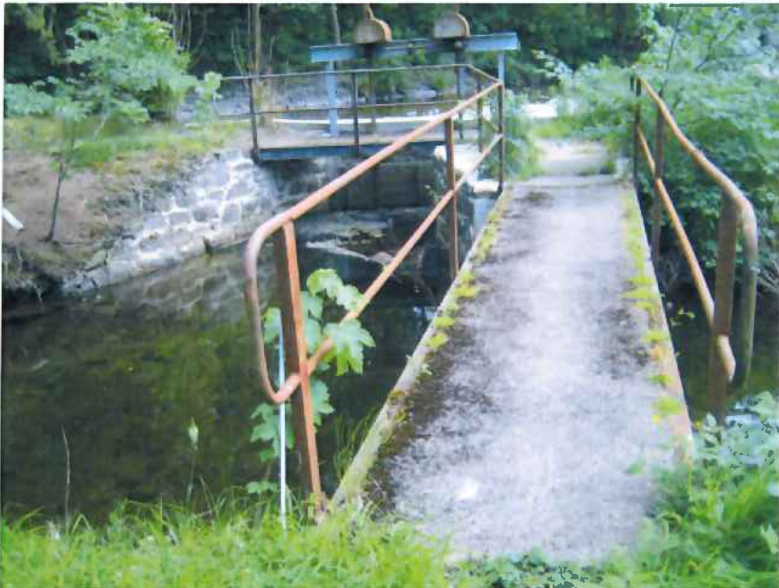
Bild Nr. 15 – Blick von Westen auf die Wehranlage. Im Vordergrund die Brücke über den Unterwasserkanal; links davon ist die Einlaufschleuse zum Düker zu sehen.
