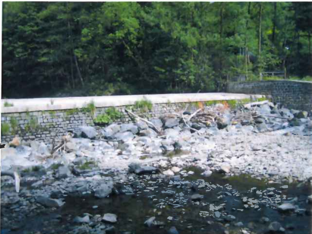
Bild Nr. 13 – Blick von unten auf den östlichen Teil des Wehrs V vom westlichen Ufer aus.
