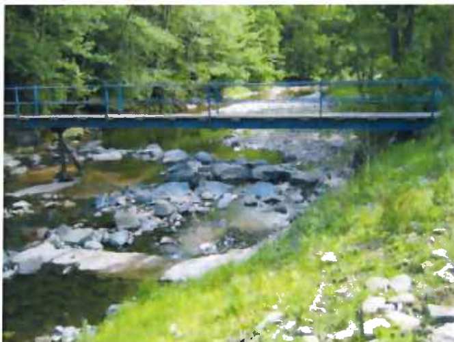
Bild Nr. 11 Brücke und Druckrohrdüker mit Sohlgleite aus Wasserbausteinen in Fließrichtung der Sieber aufgenommen
