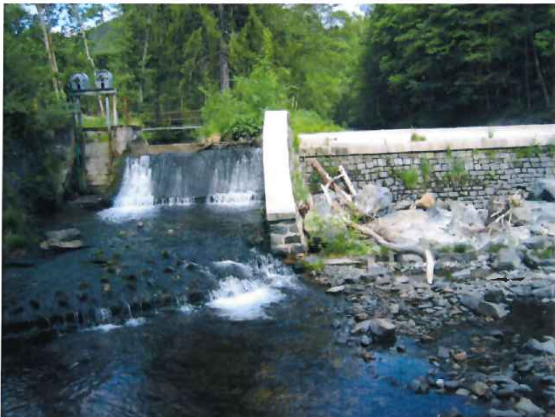
Bild Nr. 14 – gleiche Position wie bei der Aufnahme von Bild 13; Blick auf den westlichen Teil des Wehrs. In der Bildmitte die mittlere Wehrwange, links daneben der Überlauf des Unterwasserwasserkanals mit Schleuse.
