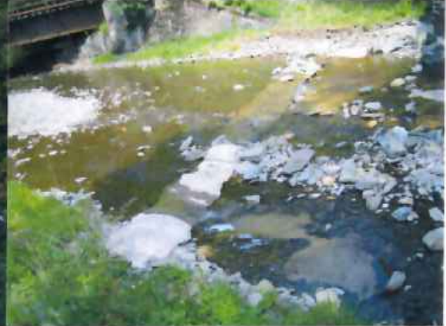
Bild Nr. 10 Druckrohrdüker im Flubett unter der Sieber mit Beton ummantelt zur Turbine
