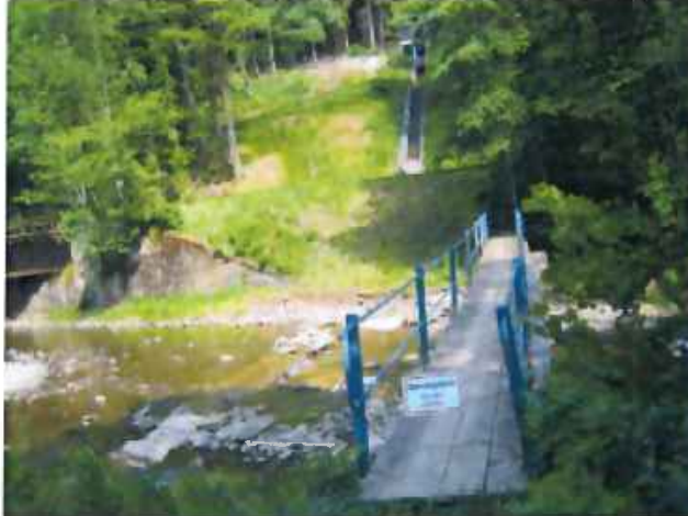
Bild Nr. 9 Wasserschloss, Druckrohrdüker und Brücke, links daneben die Trasse des Druckrohrdükers
