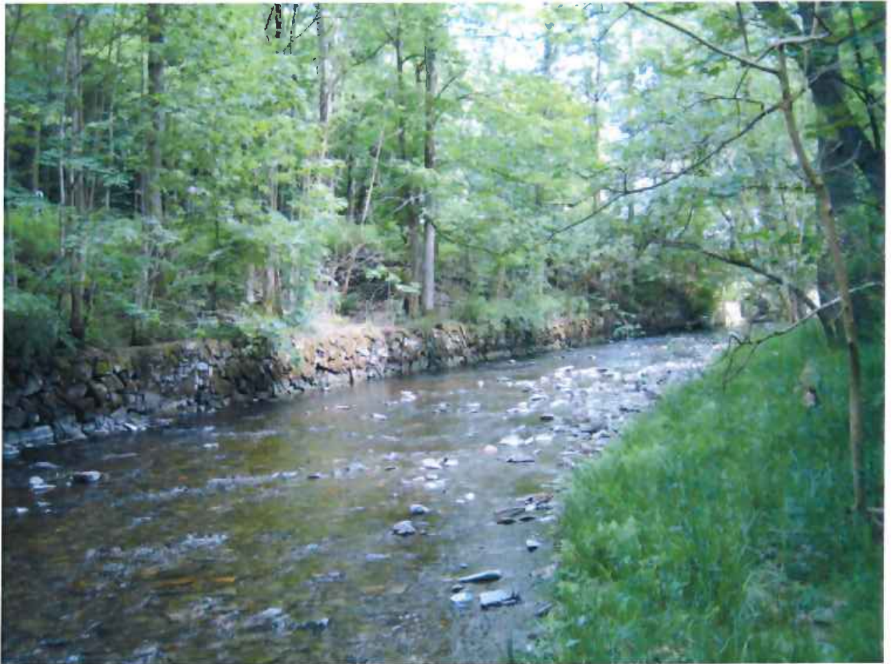
Bild Nr 8; Ufermauer des Wehrs aus Naturstein am Prallhang der Sieber. Ende des verpachteten Bauwerks rechts im Bild ist der Beginn der Betonmauer zur Sicherung des Grundstücks „Waldgasthaus Paradies“.
