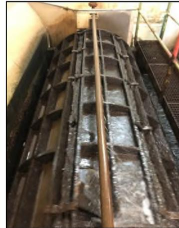
*Abbildung 3-6: Vorkehrungen Fischschutz am Einlauf Turbinenhaus (Heizkraftwerk)*
